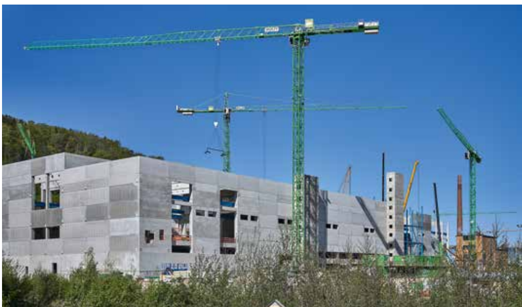
Die Glass GmbH Bauunternehmung setzt drei eigene Wolff-Krane beim Bau einer Papierfabrik in Aalen ein. Zu den Kranen, die in Glass-Hausfarben lackiert sind, gehören auch zwei Wolff 7534 clear.
