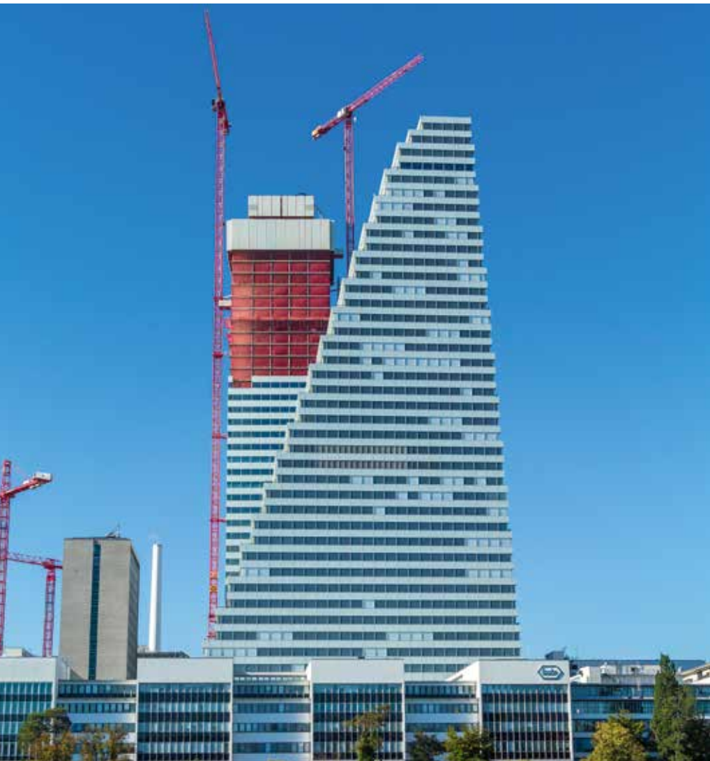
Am Roche-Tower (Bau 2) in Basel stehen im Moment mit 228 und 227 m die beiden höchsten jemals in der Schweiz aufgestellten Baukrane, zwei Wolff 7534.16 clear.
