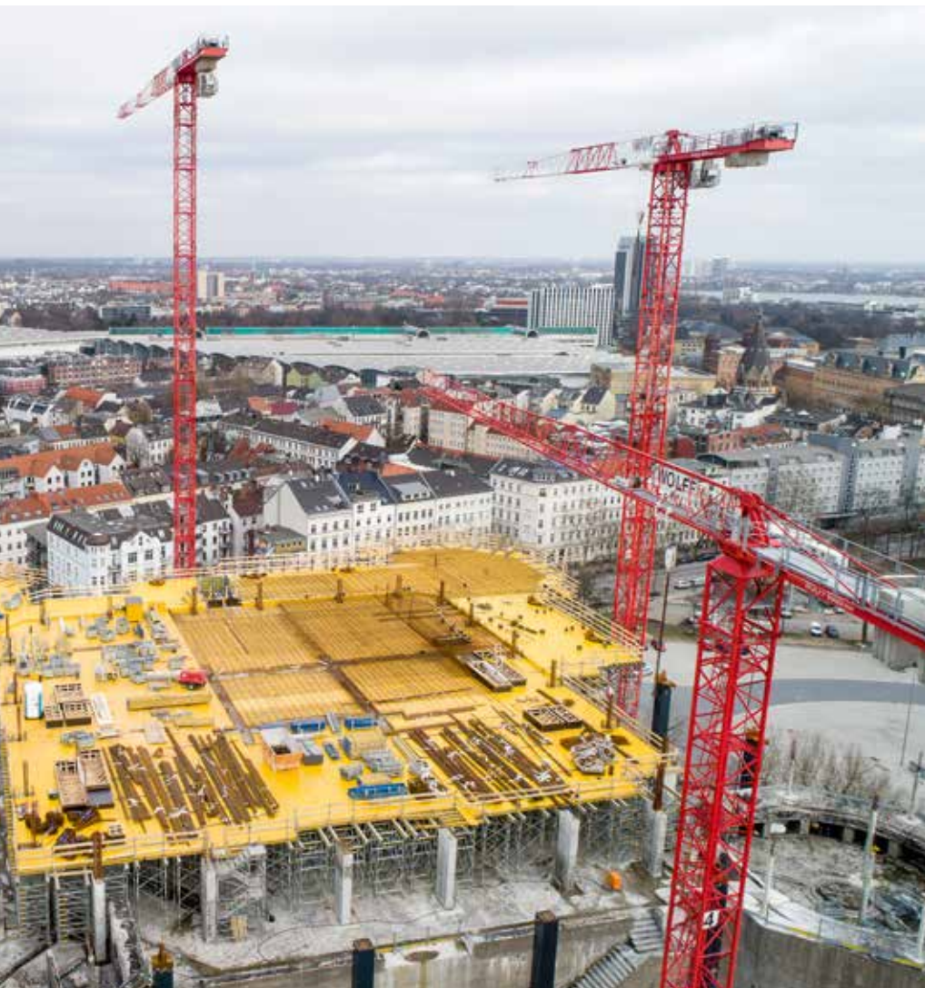
Die Aufstockung des Hamburger Flakbunkers in St. Pauli erfordert eine komplexe Baustellenlogistik.
