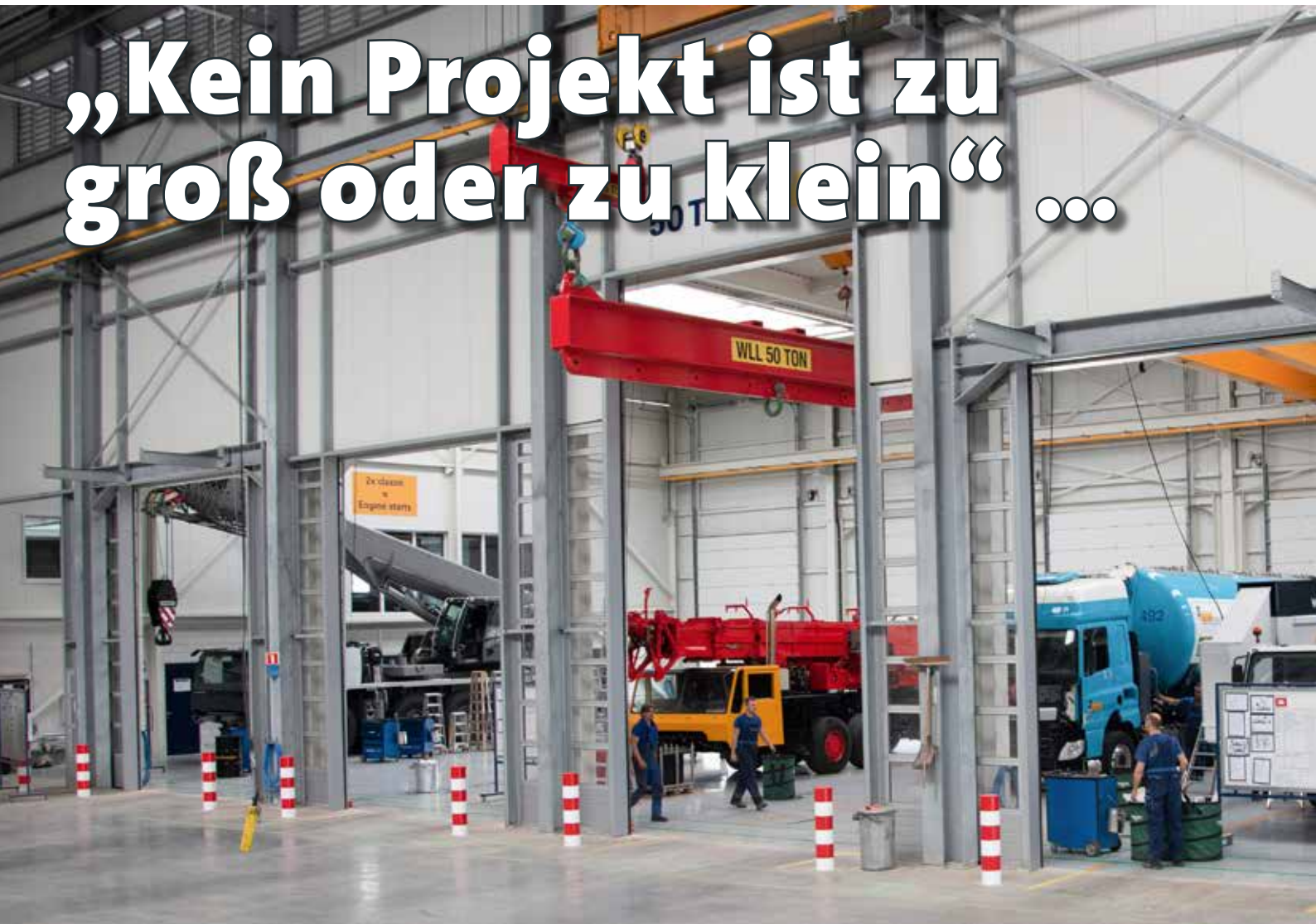
Die Hallenkrane bieten 50 t Tragfähigkeit.
