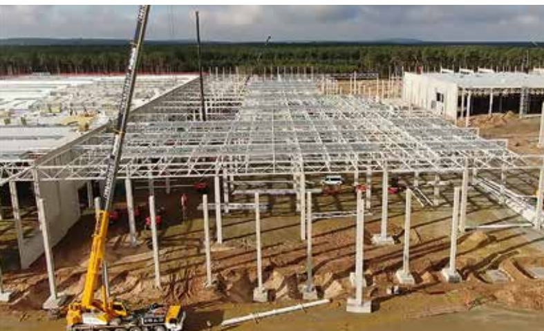
Montage der Dachbinder.
