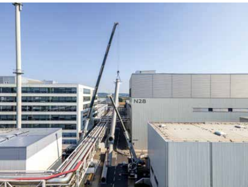
Aufrichten: Das Krando von BKL hat das erste Kaminsegment am Haken. Der 230-Tonner hebt oben, der Nachführkran hält das Bauteil unten.
