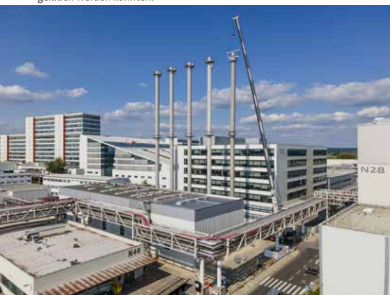
Das Kran-Duo von BKL hat es geschafft: Der rund 55 Meter hohe Schornstein steht als Fünfter im Bunde.
