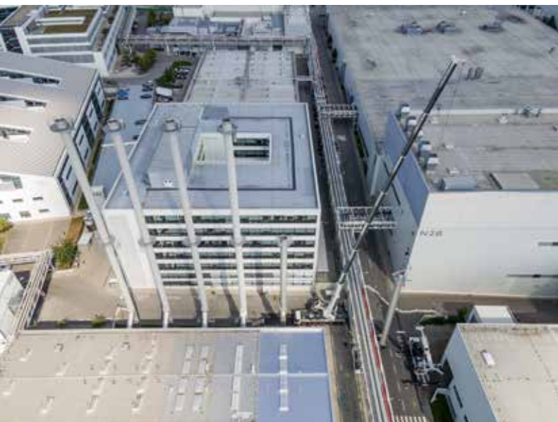
Anheben Segment 2: Aus der Vogelperspektive sieht man den Standplatz des LTM 1230-5.1. Der technische Außendienst von BKL stellte den Kran dort, da die Kaminsegmente nur an einer bestimmten Position von den Lkw geladen werden konnten.
