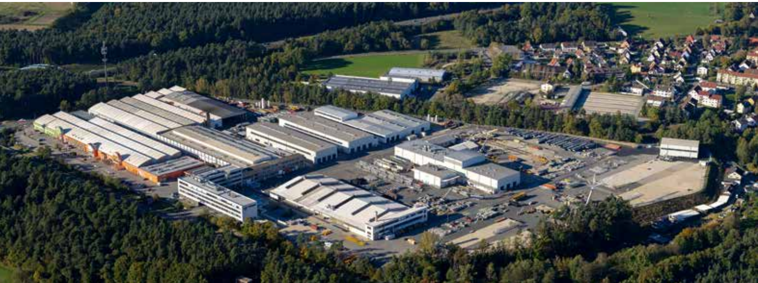
Der Standort Lauf an der Pegnitz soll zu einem Kranträgerwerk umgebaut werden.
