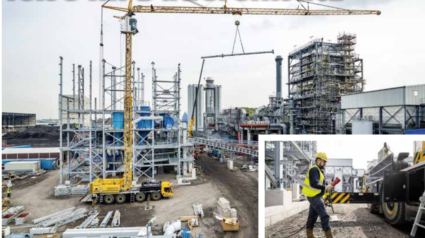
Platzsparer: wenig Raum stand auf der Baustelle dem MK 88 Plus von Kraanverhuur Boekestijn beim Bau einer Recyclinganlage in Rotterdam zur Verfügung. Fahrer Danny van Vliet zapft hier die Energie für seinen Kran aus dem Stromnetz der Baustelle.
