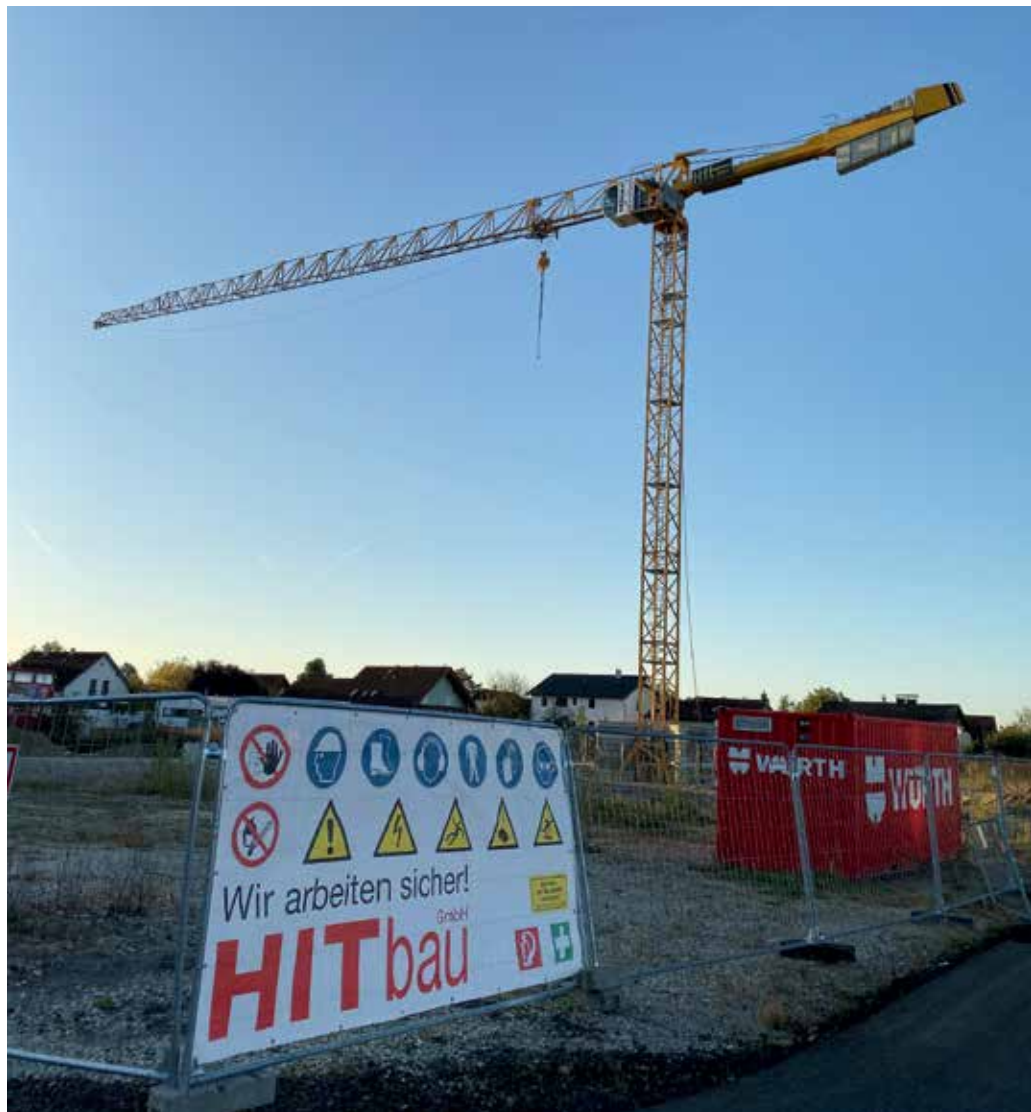
Laurer Kran auf HITbau-Baustelle.
