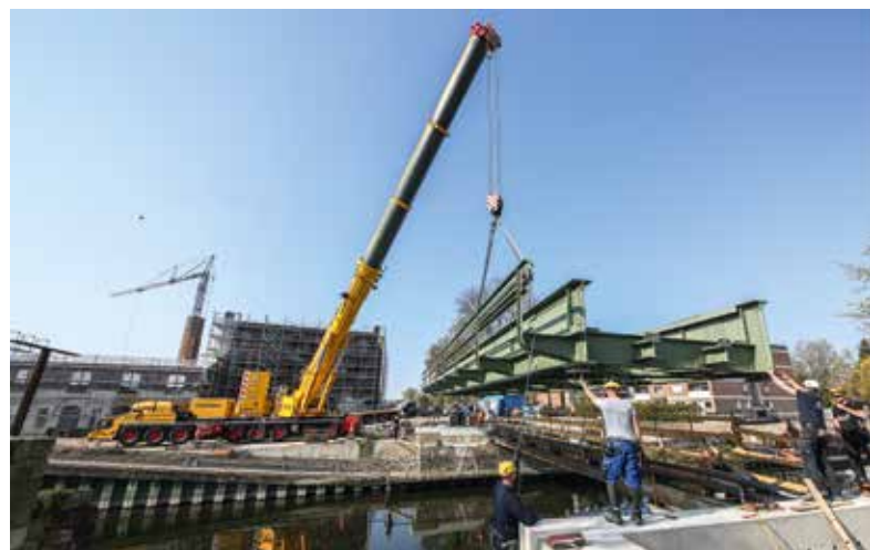
... und beim Einhub die 110-KV-Stromleitung direkt neben der Brücke.
