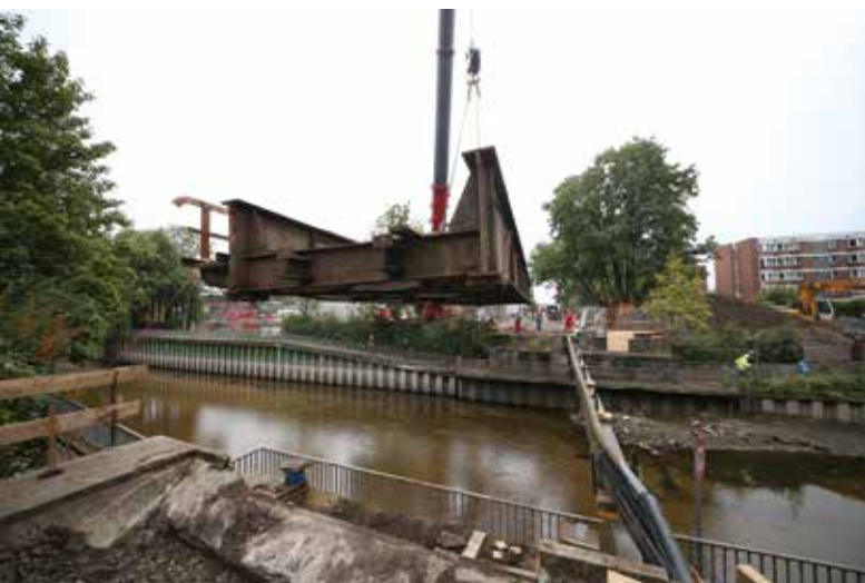
LTM 1.500 8.1. von Schares beim Aushub der Brücke.
