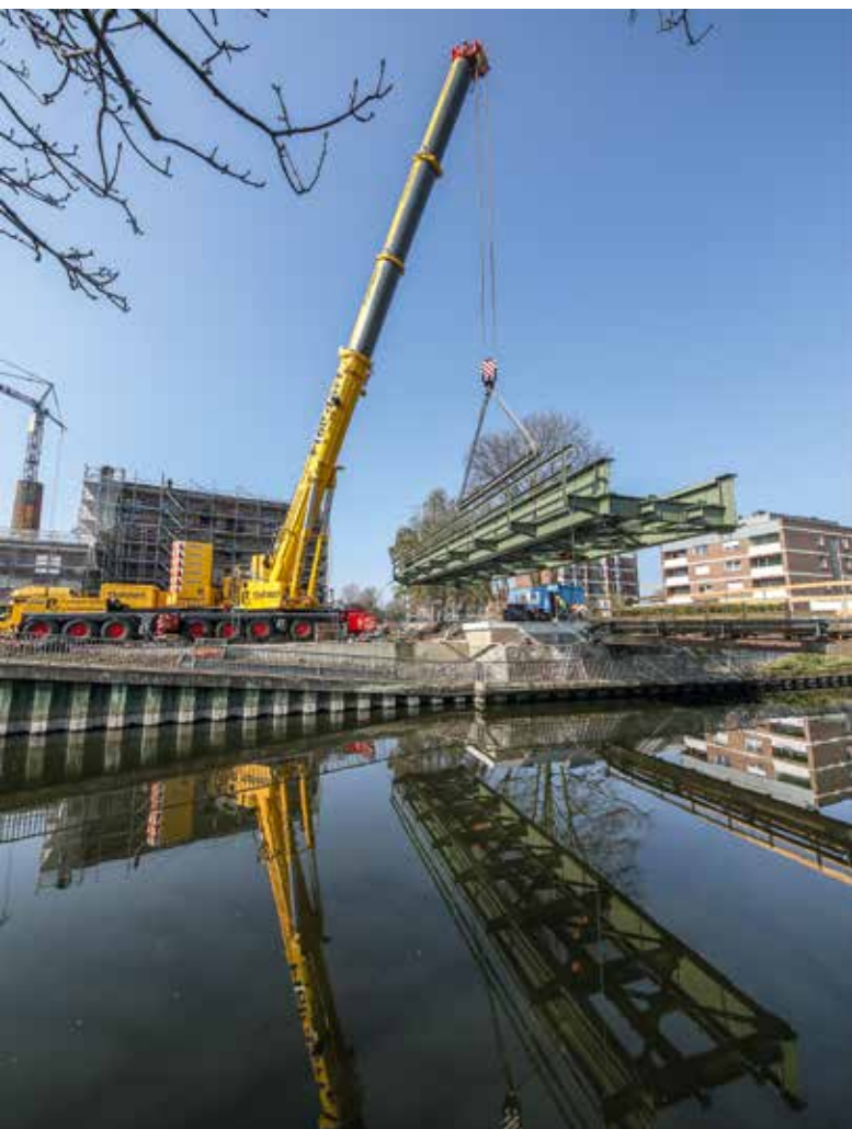
Die neue Brücke wiegt 51,5 Tonnen.
