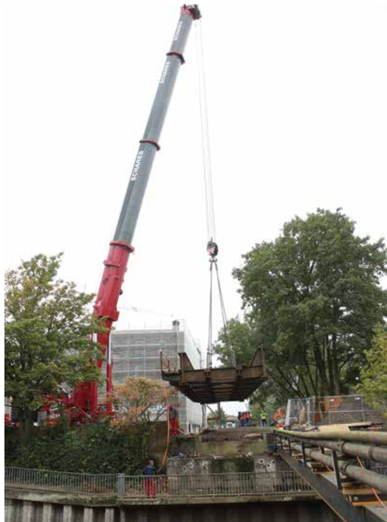
Besonderes Augenmerk galt beim Aushub ...
