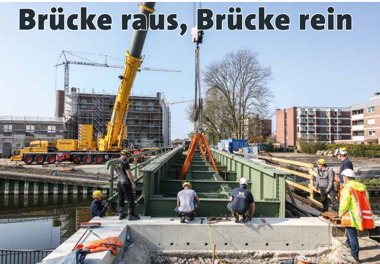
LTM 1.650 8.1 beim Einhub der Brücke.
