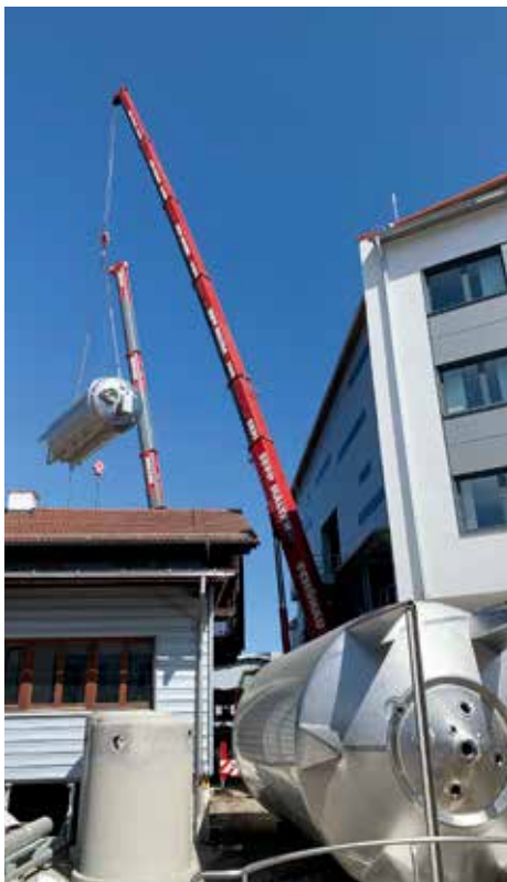
Die ersten Edelstahl tanks werden eingebracht und aufrecht aufgestellt.
