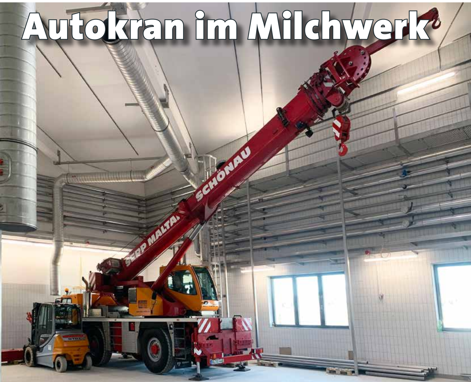
Bereit zum Einhub der Tanks.
