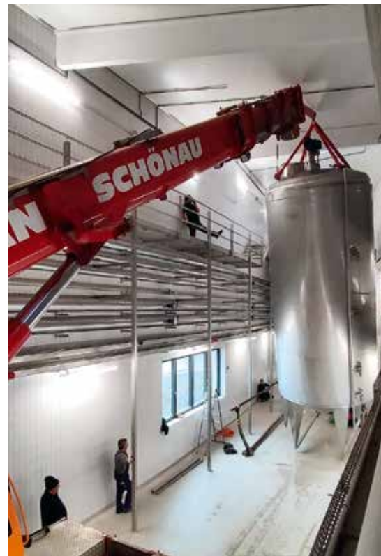
Die ersten Edelstahl tanks werden eingebracht und aufrecht aufgestellt.
