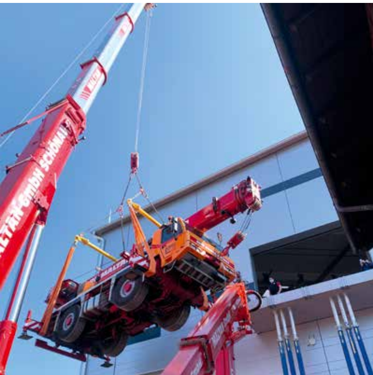
Ein Faun ATF 40G-2 wird in die Halle der Milchwerke BGL eingehoben.
