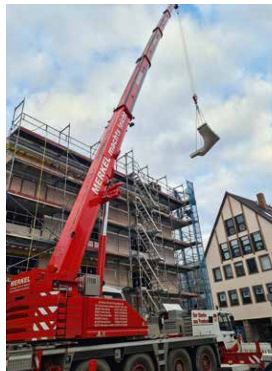
Der Tadano ATF 70G-4 beim Einhub von 5 Tonnen schweren Betonelementen.
