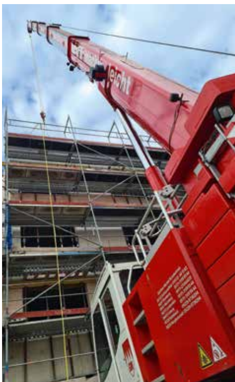
Der Tadano ATF 70G-4 beim Einhub von 5 Tonnen schweren Betonelementen.
