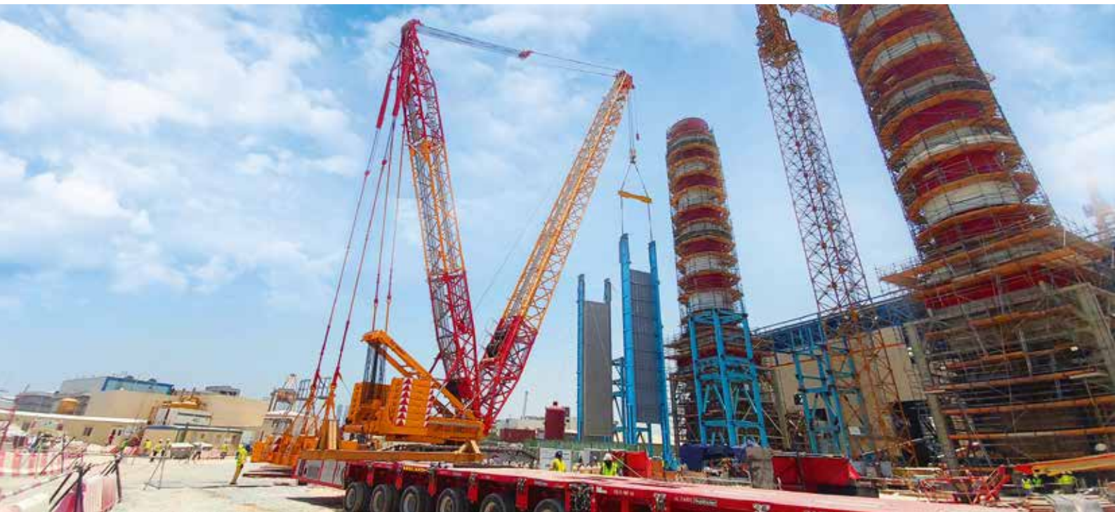
Demag Raupenkran CC 3800-1 auf Kraftwerksbaustelle Layyah, VAE.
