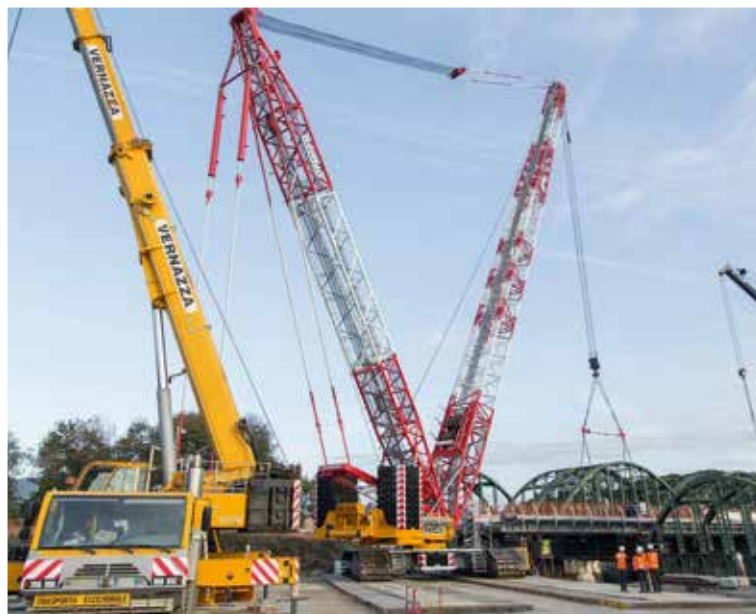
219: Ersteinsetzung des Demag CC 3800-1 von Vernazza beim Demontieren einer Eisenbahnbrücke.
