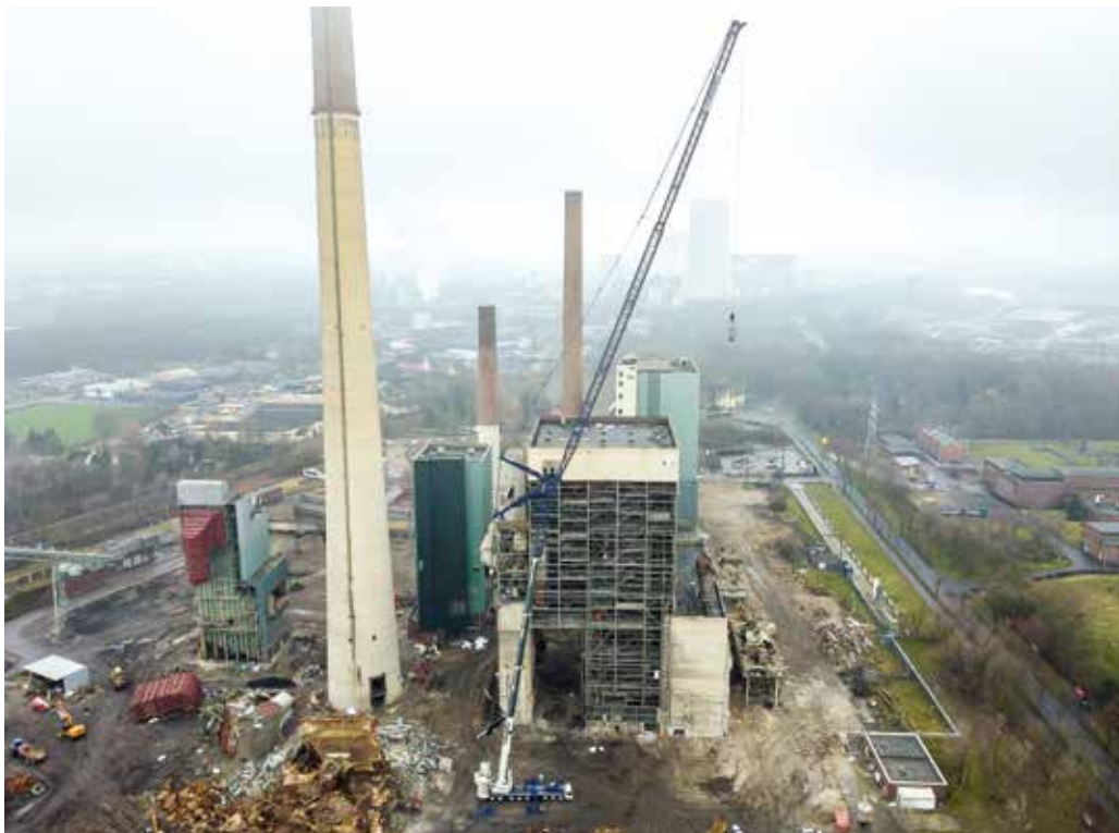
Die Y-Abspannung erhöht die Tragfähigkeit und verbessert die Seitenstabilität des LTM 1650-8.1.
