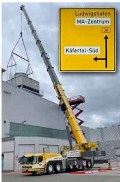
Einsatz Demontage eines Kühlers im Turbinenwerk.
