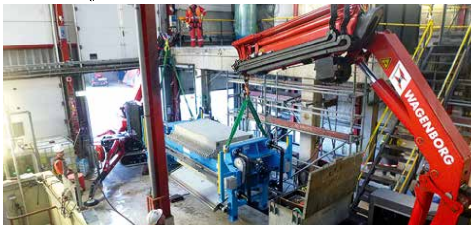
Zwei Minikrane heben eine 10 Tonnen Filterpresse auf eine Rampe.
