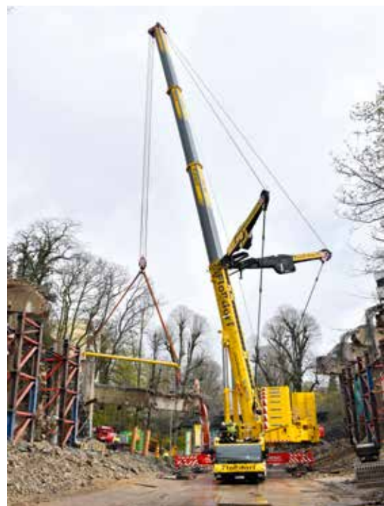
LTM 1650-8.1 beim Brückenabriss in Mönchengladbach.
