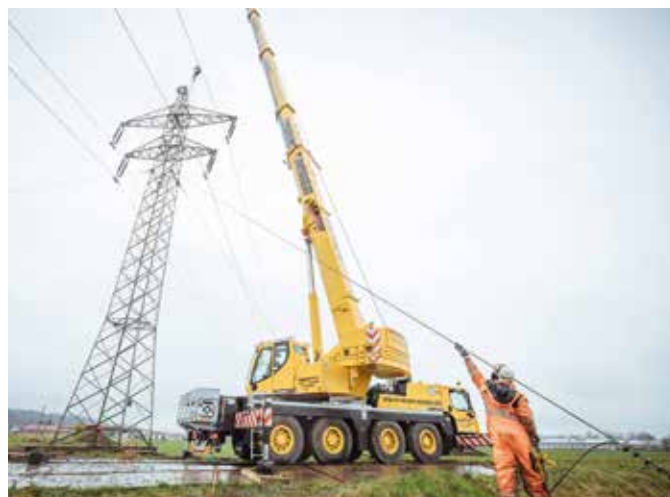
LTM 1070-4.2 bei der Montage von Hochspannungsmasten zwischen Eching und Viecht.
