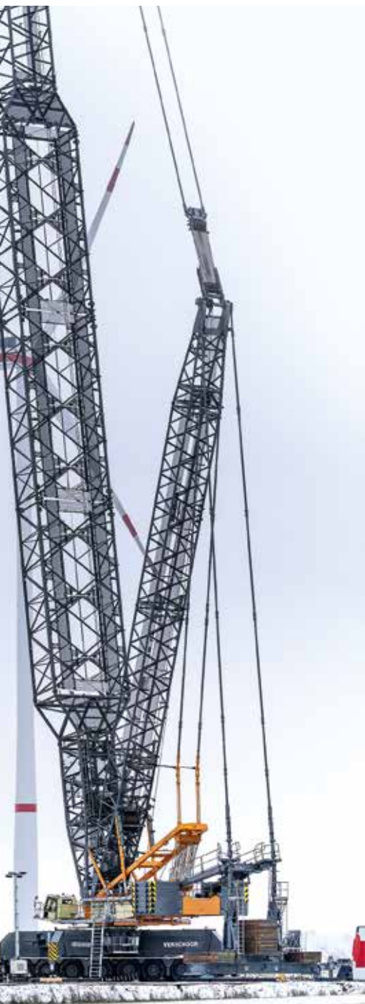
Liebherr LG 1750 mit SX3-Auslegersystem bei Arbeiten in einen Windpark in Nordostdeutschland.
