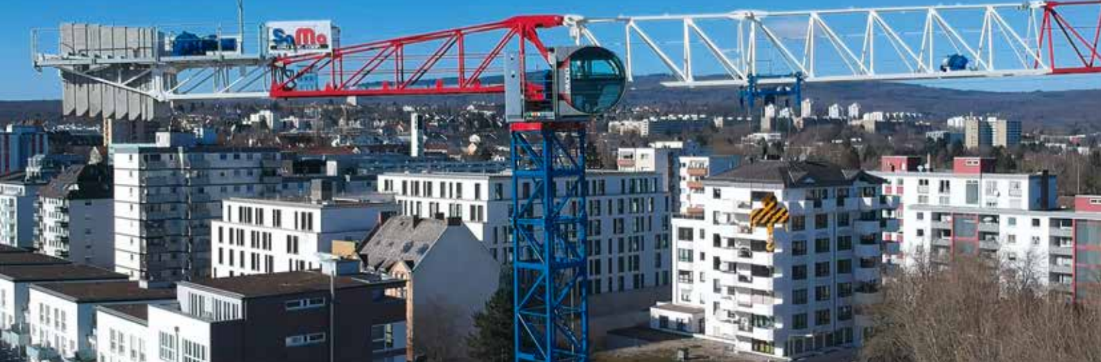
Raimondi MRT234 beim Einsatz in Wiesbaden.
