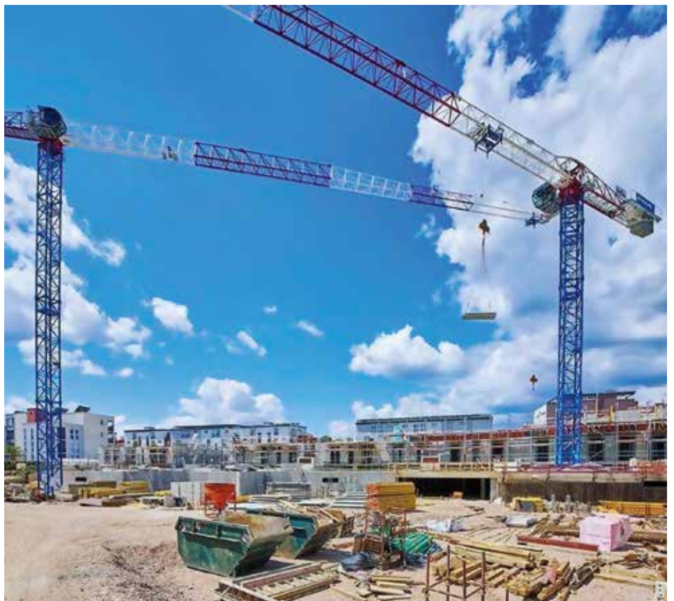
Zwei Raimondi Oberdreher auf der Baustelle in Wiesbaden.
