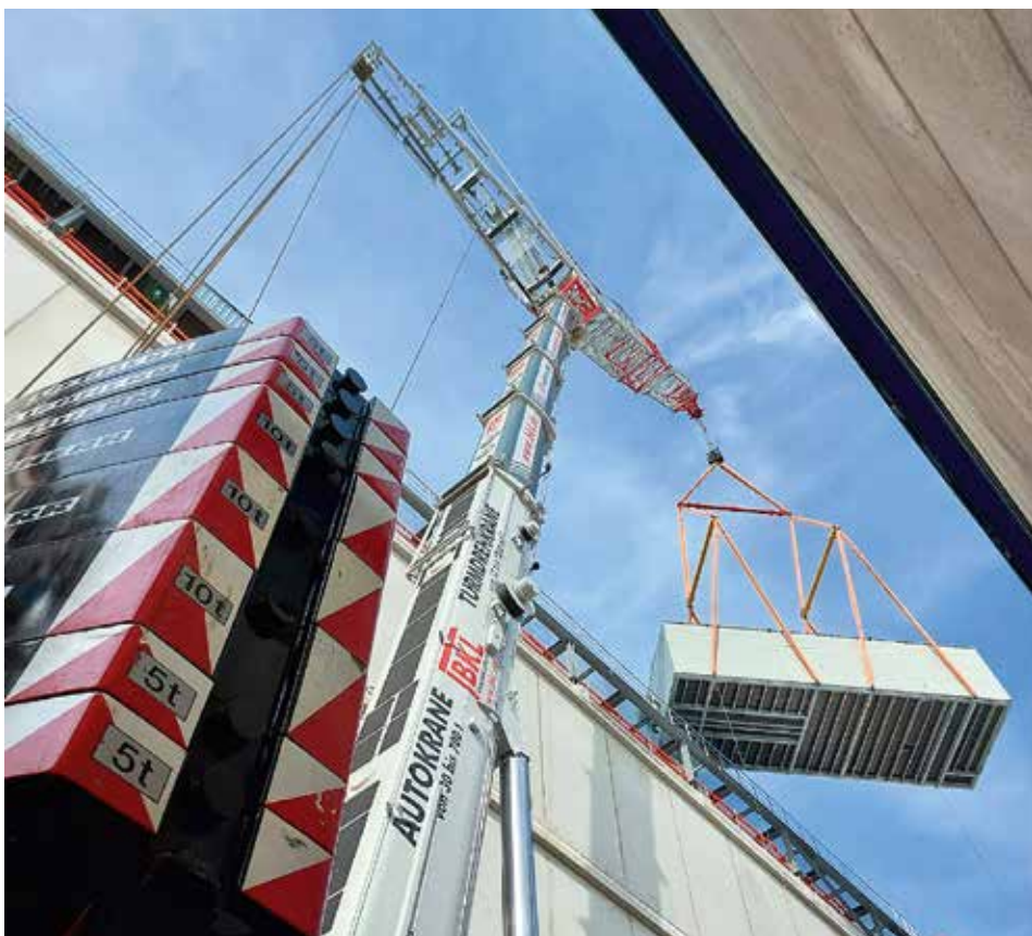
Mit einer durchdachten Konfiguration platzieren die Autokranspezialisten von BKL Frankfurt den 450-Tonner zwischen dem Bestandsgebäude und dem Neubau.
