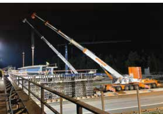
Liebherr LTM 1650 und LTM 1450 im Tandemhub – Teamwork bei Planung und Ausführung dieser Brückenbaustelle in Offenbach.
