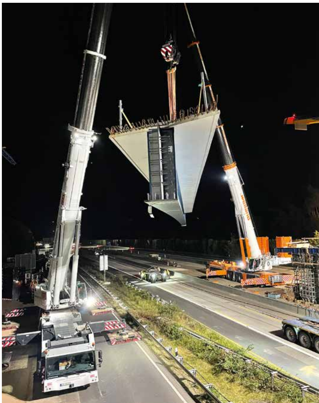
Liebherr LTM 1650 und LTM 1450 im Tandemhub – Teamwork bei Planung und Ausführung dieser Brückenbaustelle in Offenbach.
