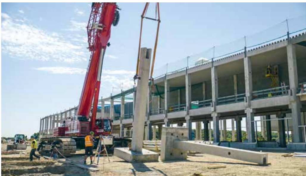
Nach dem Tausch der Anschlagmittel gegen Tragstangen ...
