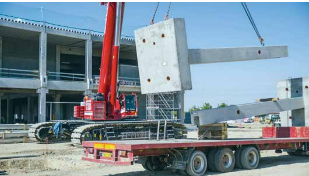
Zunächst werden mithilfe des Krans die angelieferten Betonstützen vom Tieflader gehoben.
