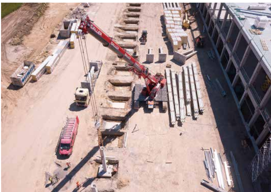
... wurden die Betonstützen passgenau auf den Sockeln positioniert.
