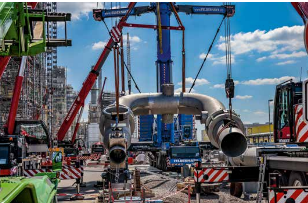
Bei einem Hub musste eine Rauchgasleitung „Telefonhörer“ und „Krückstock“ genannt platziert werden. Foto: Simon-Werbung
