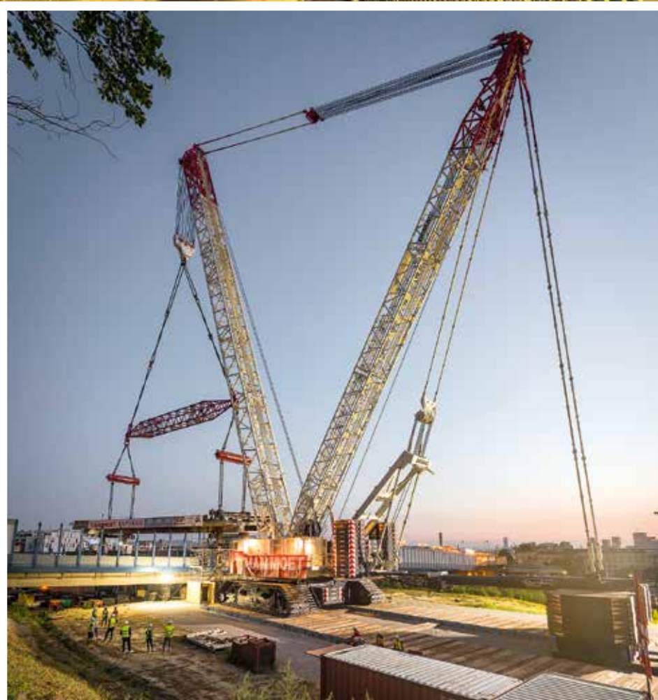
Ein ‚integrierter Stinger‘ am Superlift des 1.600 t-Raupenkran ermöglichte schnelle Lastwechsel.
