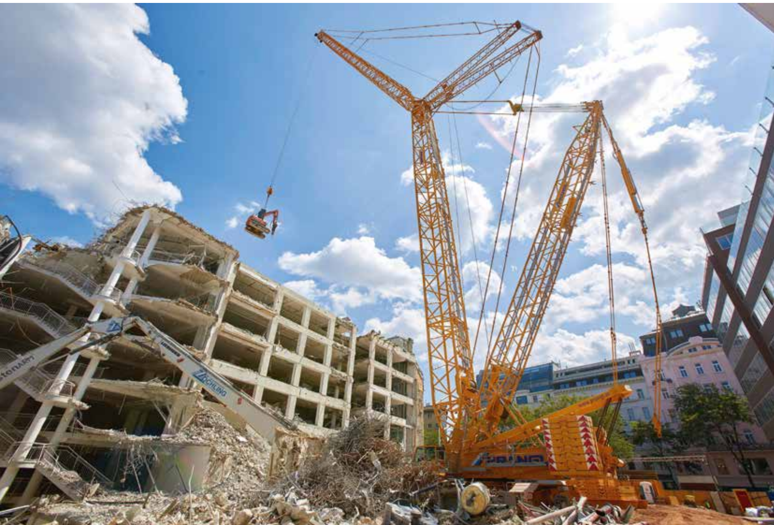
Raupenkran von Prangl bei Abrissarbeiten in Wien.
