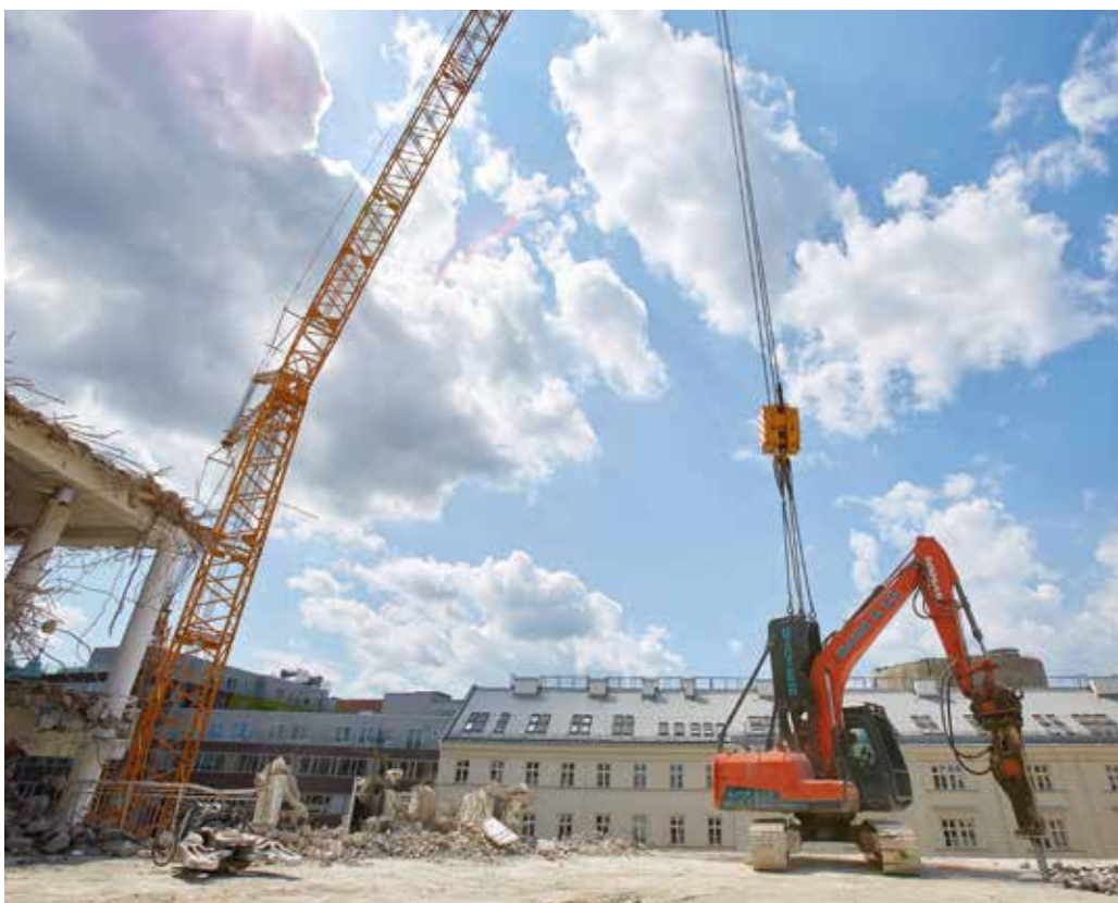
Gewichtsreduktion durch „Bagger am Seil“.
