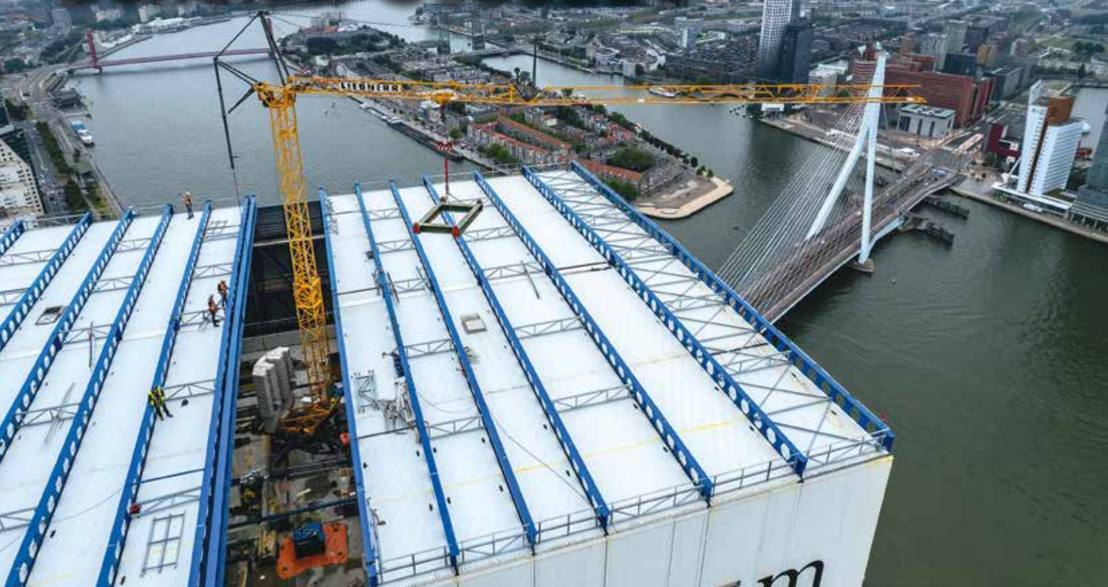
Liebherr 34K Schnelleinsatzkran im Einsatz auf dem Zalmhaven I.
