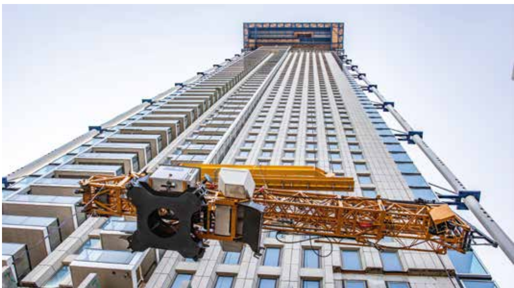
Portalkran befördert Liebherr 34K-Schnelleinsatzkran auf den Zalmhaven I.
