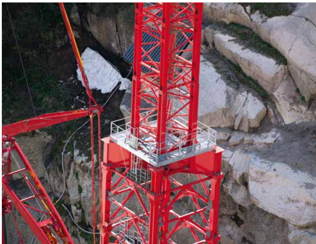
Übergang der Turmelemente TV 60 auf TV 33.
