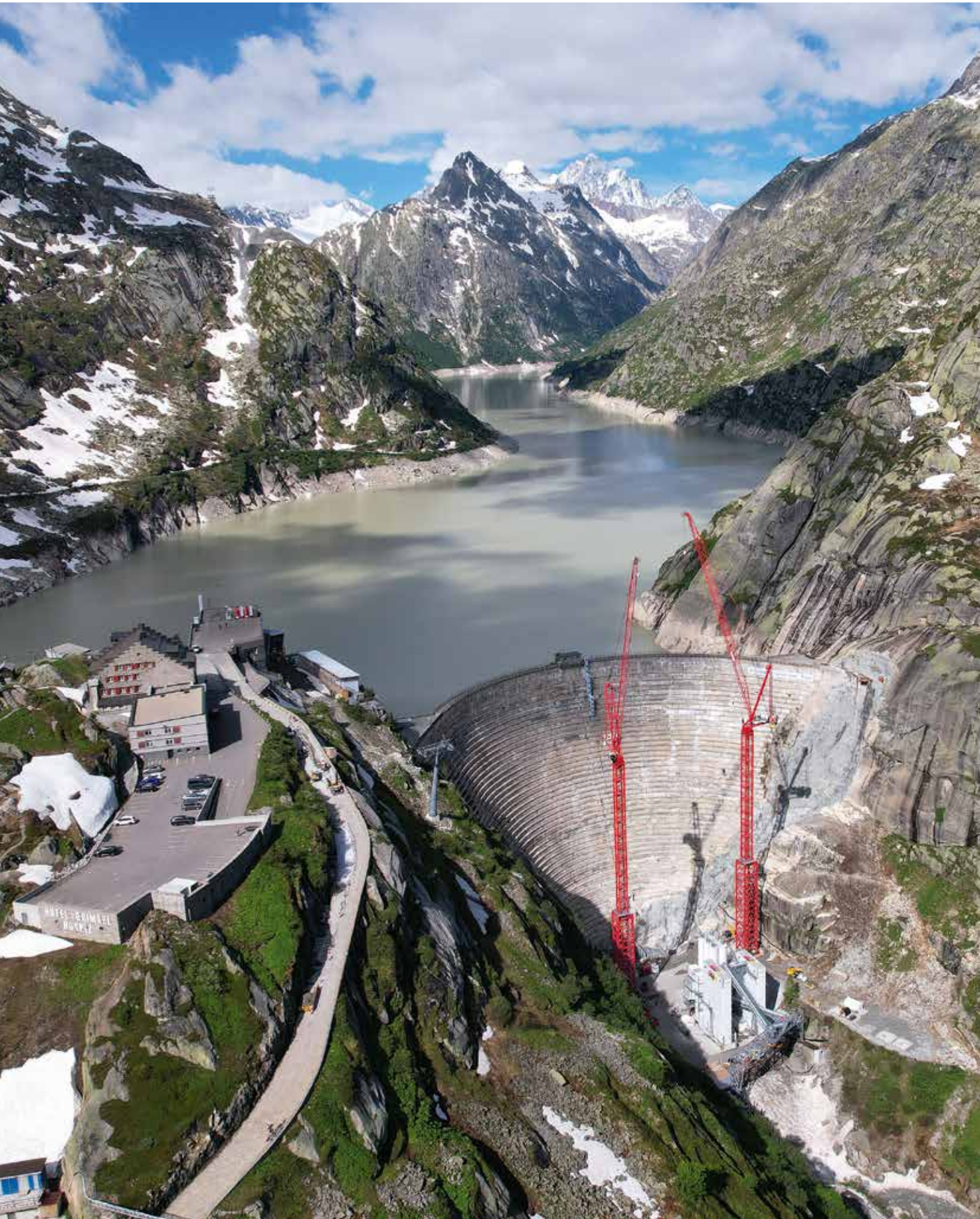
Die Baustelle Ersatzstaumauer Spittalamm am Grimselsee (im Überblick).
