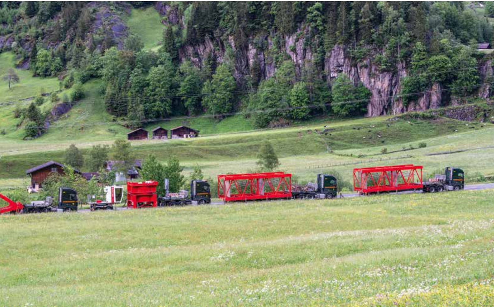
Just-in-Time-Anlieferung der Turmsegmente.
