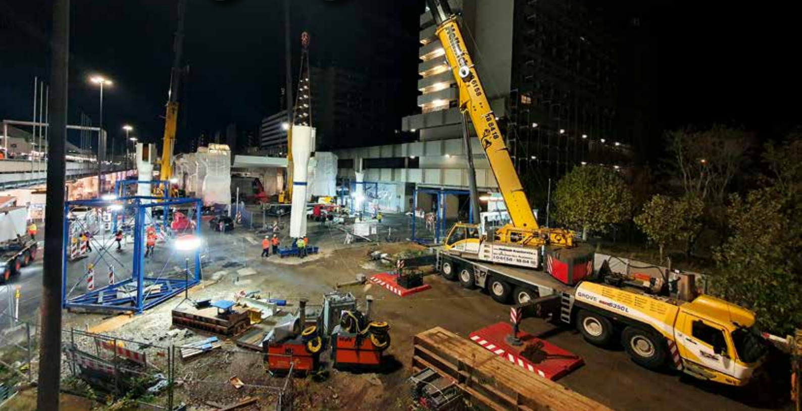
Arbeiten unter extremen Platzbedingungen – der Grove GMK 6300L im Tandemhub mit seinem Kollegen mit einem Grove GMK 5130-1.
