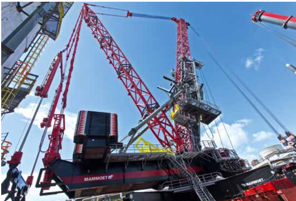
Der Ausleger des Krans wird vertikal aufgestellt, abseits von lebenden Anlagen und Zufahrtsstraßen.
