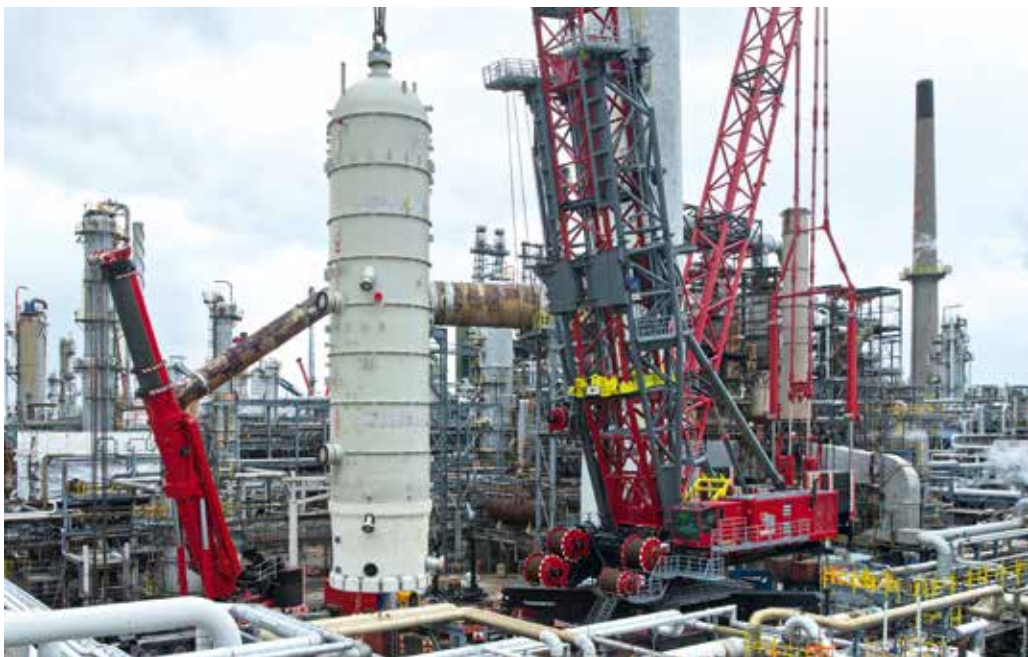
Der FOCUS30 hebt das neue Schiff vor Ort in Position.
