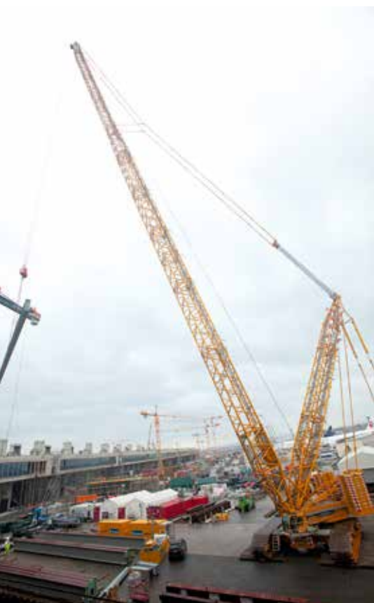
Demag Raupe CC3800, 24 Tonnen-Stahlbinder-Hub, Baustelle Terminal 3.
