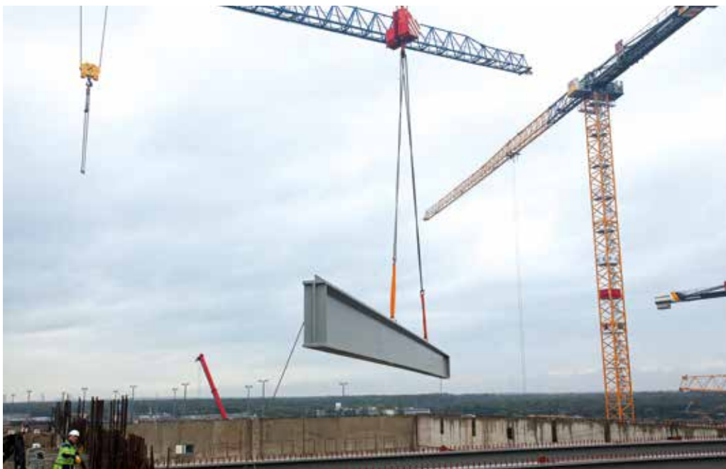
Einhub eines Stahlbinders auf dem „Marktplatz“-Dach vom Terminal 3.
