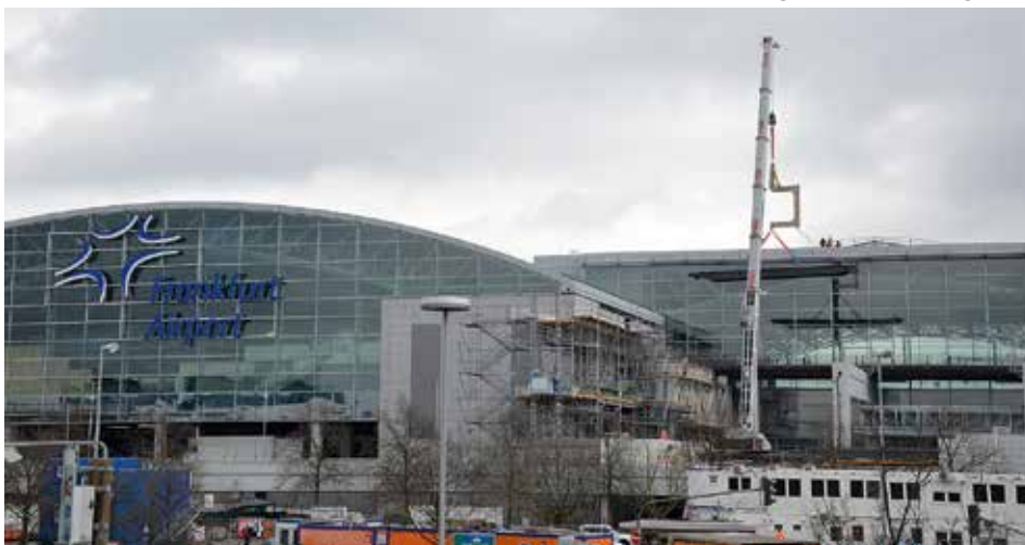
Jeder Zentimeter zählt – das gilt bei der Krangestellung auf dem Vorfahrtstisch ebenso, wie beim Einheben der Fahrachse in das Terminalgelände. Das Autokranteam von BKL Frankfurt löste dies mit einem LTM 1300-6.2 und einer speziell angeschlagenen C-Traverse.
