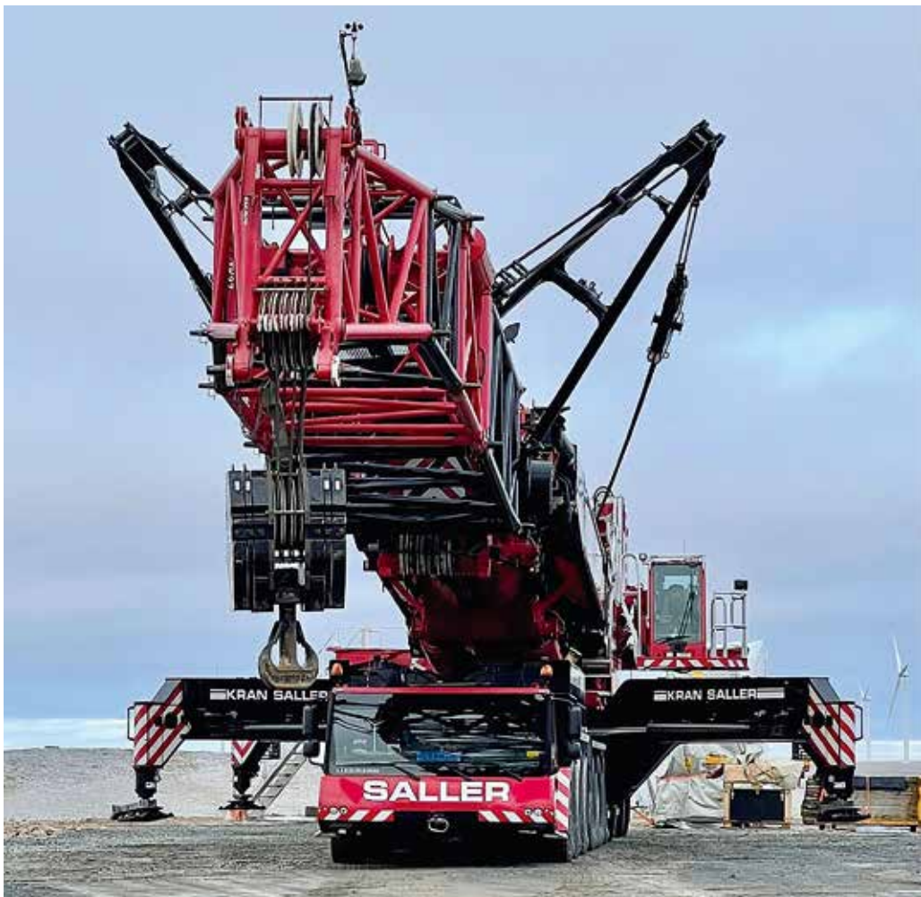
Der fertig gerüstete LTM 1750-9.1 von Kran Saller.
