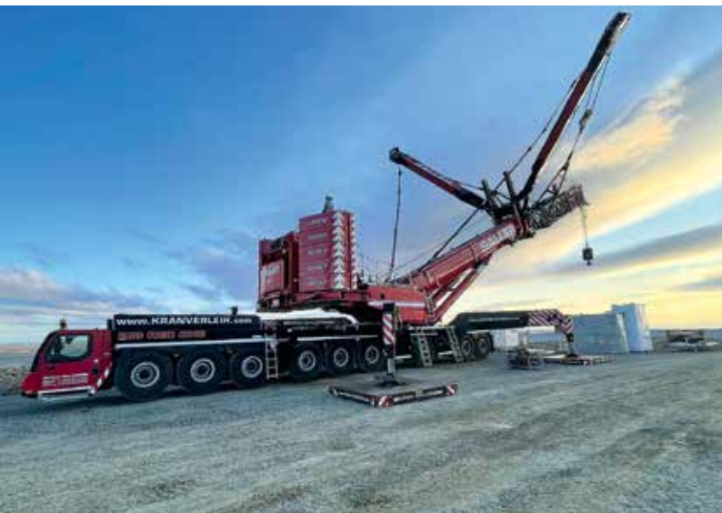
Der LTM 1750-9.1 im Rüstzustand mit 144 Tonnen Ballast.
