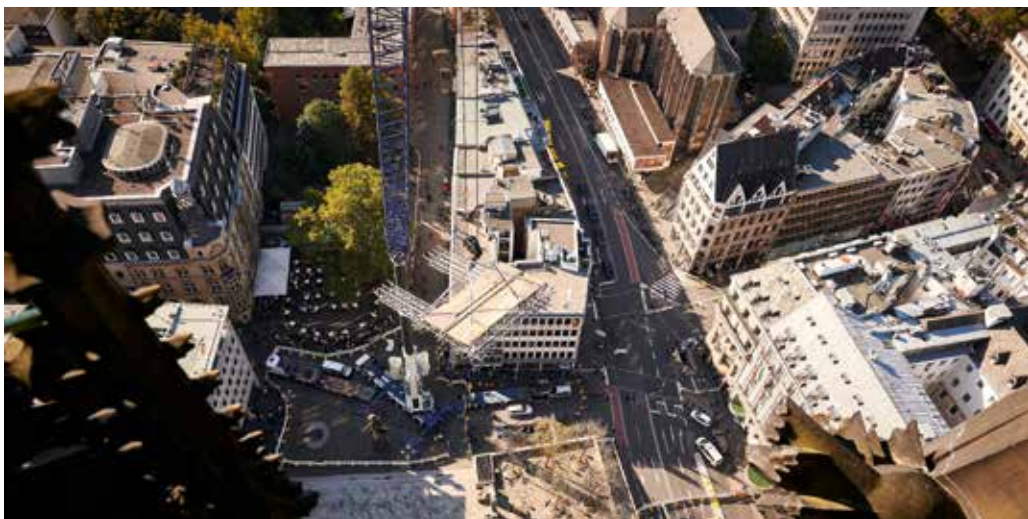
Die 65 Meter Entfernung vom Kranstellplatz zum Nordturm wurde per Ausleger überbrückt.
