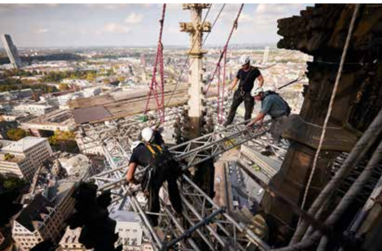
Nichts für schwache Nerven: Demontage des Gerüsts.
