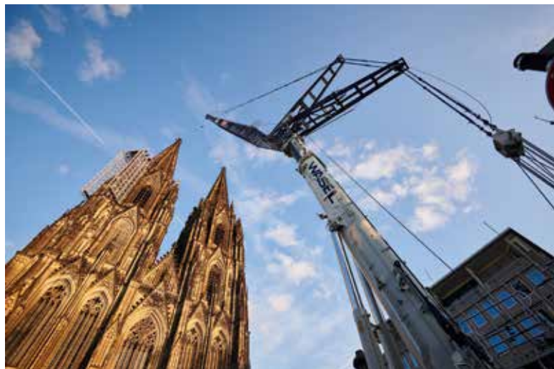
Das Gerüst hat eine Höhe von 30 Metern, hing in 104 m Höhe.
