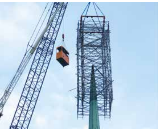
Das Stützgerüst wird vorsichtig eingehoben.
