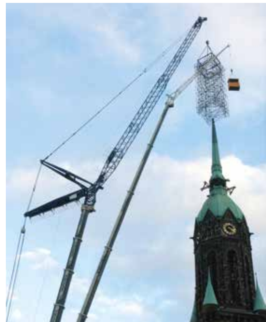
Zum Einsatz kam ein LTM 1450-8.1 mit 84 t Ballast und einer 56 m langen Wippspitze. Als Hilfskran diente ein LTM 1095-5.1 mit 23 t Ballast und einer 19 m Klappspitze.
