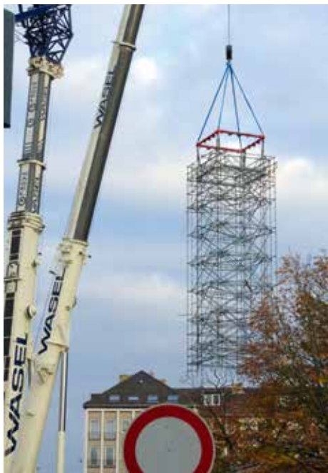
Zum Einsatz kam ein LTM 1450-8.1 mit 84 t Ballast und einer 56 m langen Wippspitze. Als Hilfskran diente ein LTM 1095-5.1 mit 23 t Ballast und einer 19 m Klappspitze.
