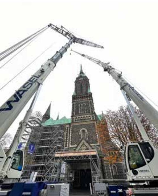
Zum Einsatz kam ein LTM 1450-8.1 mit 84 t Ballast und einer 56 m langen Wippspitze. Als Hilfskran diente ein LTM 1095-5.1 mit 23 t Ballast und einer 19 m Klappspitze.
