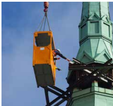
Der Statiker prüft die Konstruktion.
