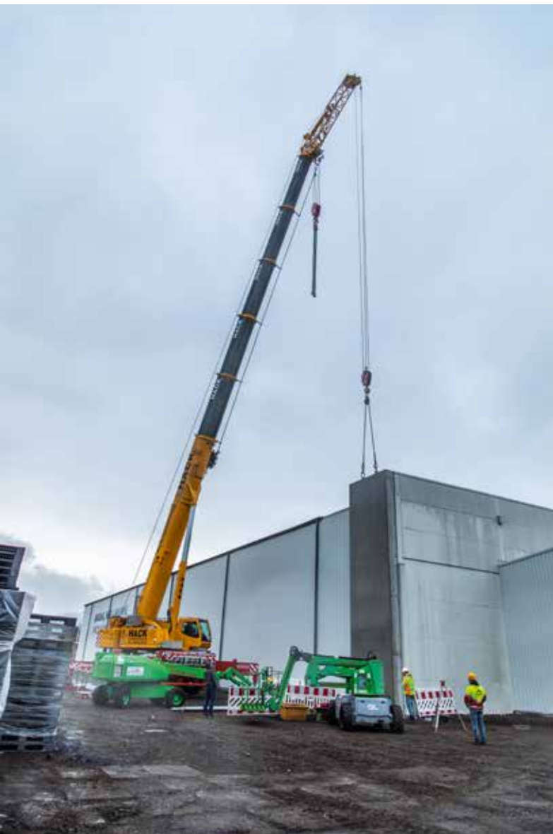
Fertigteilmontage mit Schwerlastspitze.
