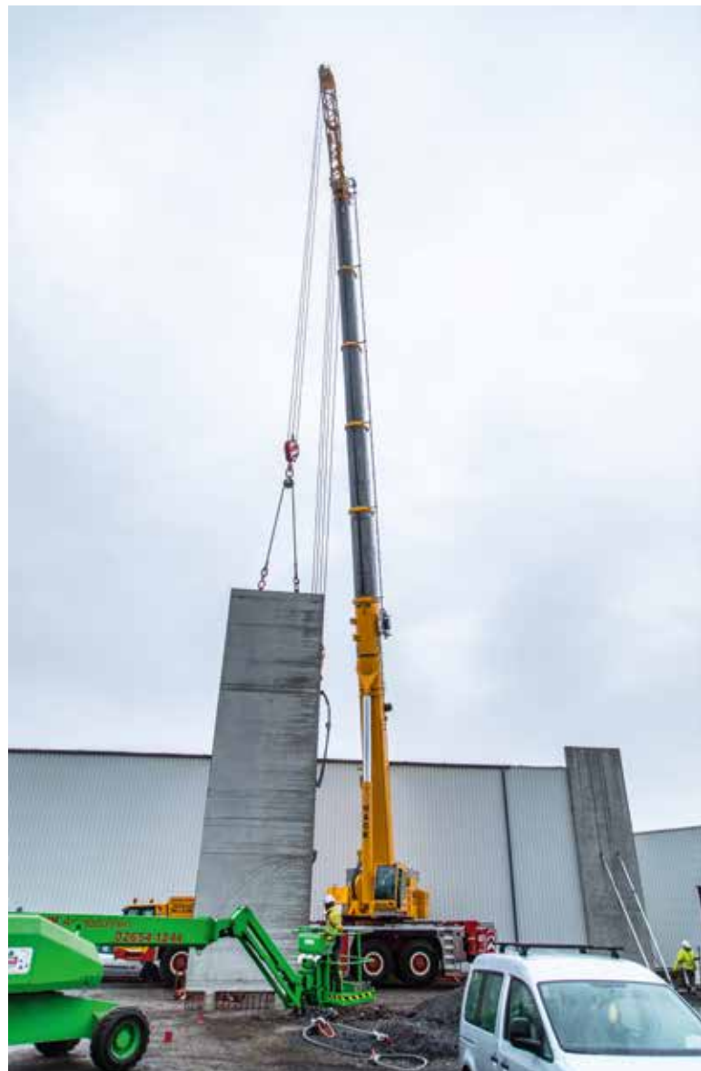
2. Winde im Einsatz zum Drehen des Betonteils.
