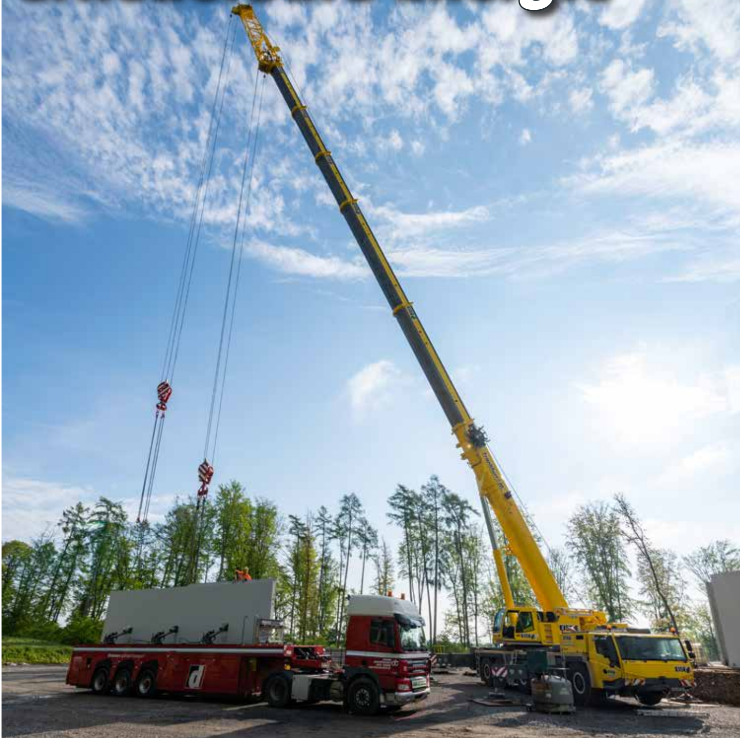
Fertigteilmontage mit zwei Winden – der ATF 220 im Windpark Fuchsstadt.
