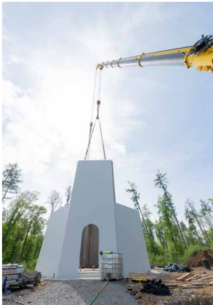
... in der Fertigteilmontage.
