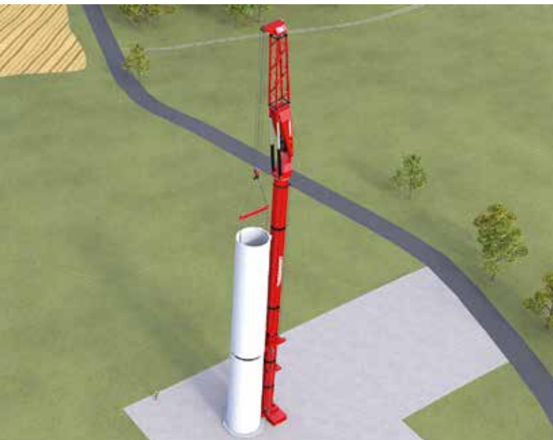
Die WTA installiert Turmabschnitte, Schaufeln und Gondeln und nutzt den Turm selbst zur Unterstützung. Eine Reihe von Klemmen verbindet die WTA mit dem Turbinenturm, so dass sie jede Hubposition erreichen kann.
