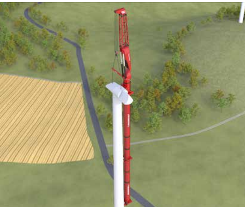
Die WTA installiert Turmabschnitte, Schaufeln und Gondeln und nutzt den Turm selbst zur Unterstützung. Eine Reihe von Klemmen verbindet die WTA mit dem Turbinenturm, so dass sie jede Hubposition erreichen kann.
