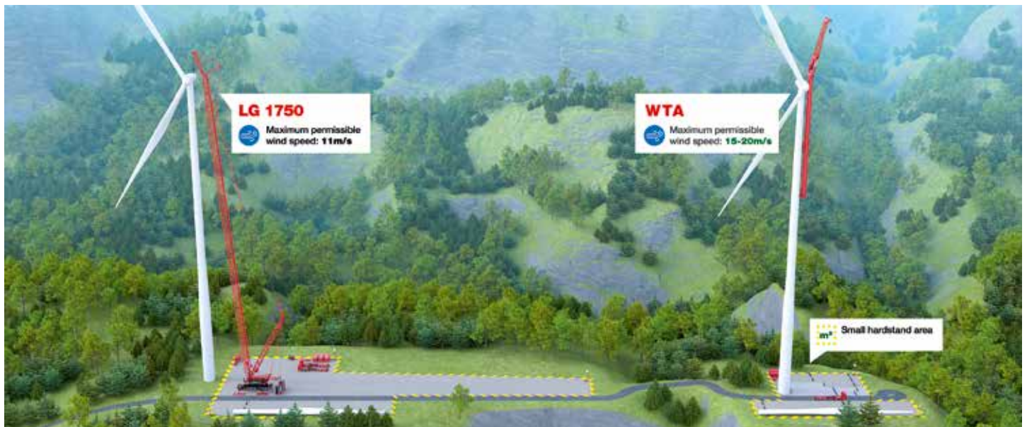
Die WTA kann mit höheren Windgeschwindigkeiten als Raupenkrane arbeiten und benötigt viel weniger Bodenabstände.
