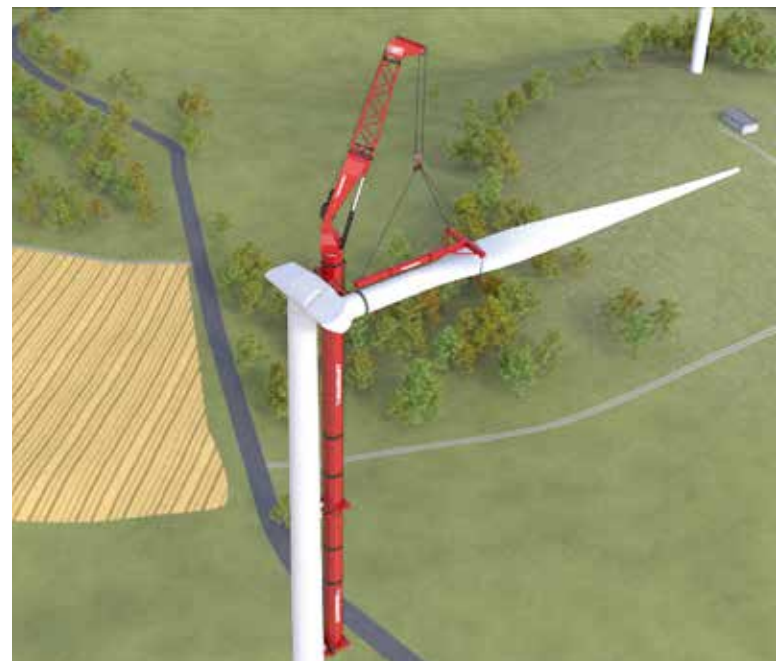
Die WTA installiert Turmabschnitte, Schaufeln und Gondeln und nutzt den Turm selbst zur Unterstützung. Eine Reihe von Klemmen verbindet die WTA mit dem Turbinenturm, so dass sie jede Hubposition erreichen kann.
