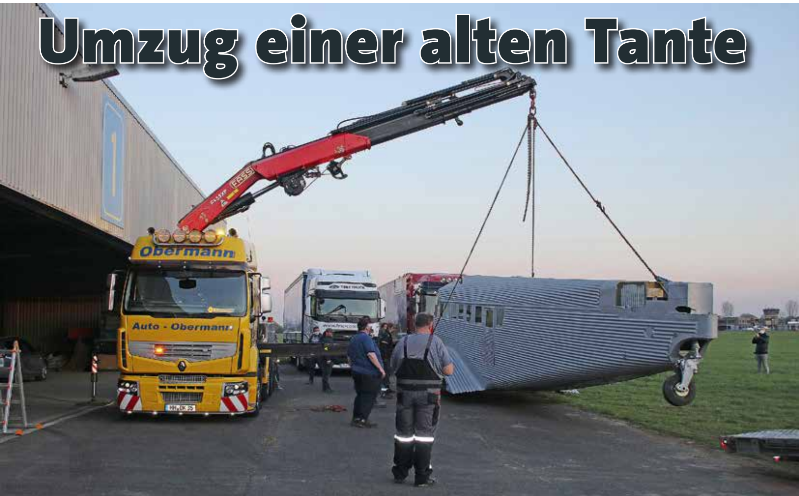
Der drei Tonnen schwere Alu-Rumpf des Fliegers am Haken des Fassi F455 XP.
