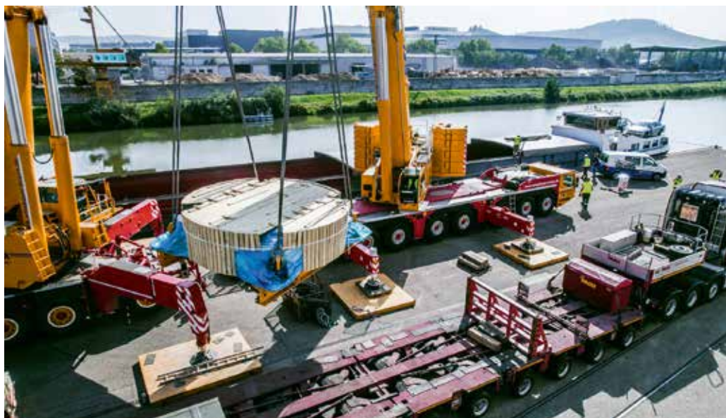
Der 125 Tonnen schwere MRT-Magnet wird zwischen beiden Kranen durchgeschwenkt ...
