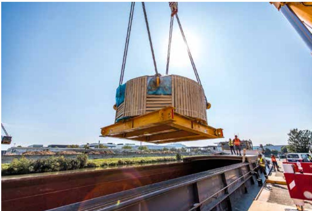
Der MRT-Magnet wird auf das Binnenfrachtschiff abgesetzt.
