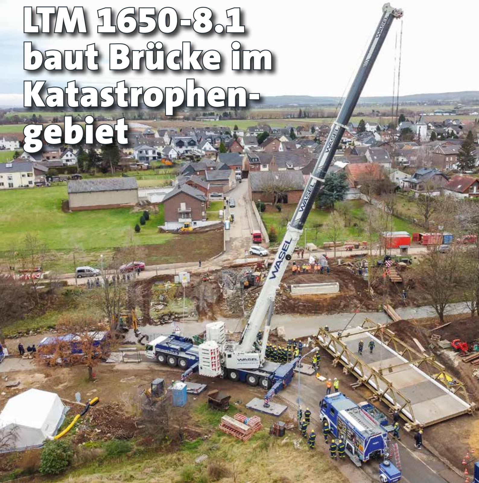
Die Behelfsbrücke am Haken des LTM 1650-8.1.
