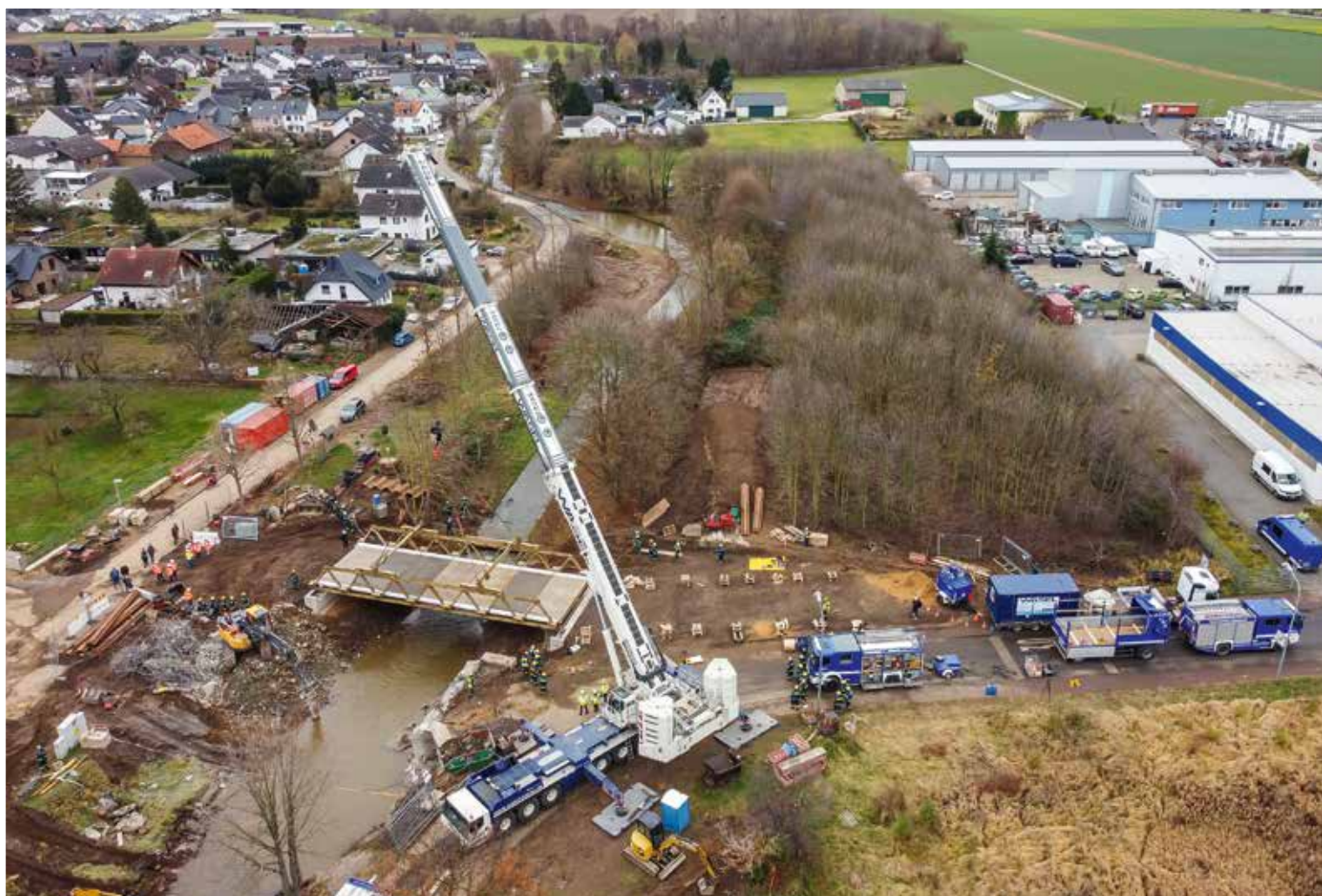
Die Behelfsbrücke wird über der Erft eingehoben.
