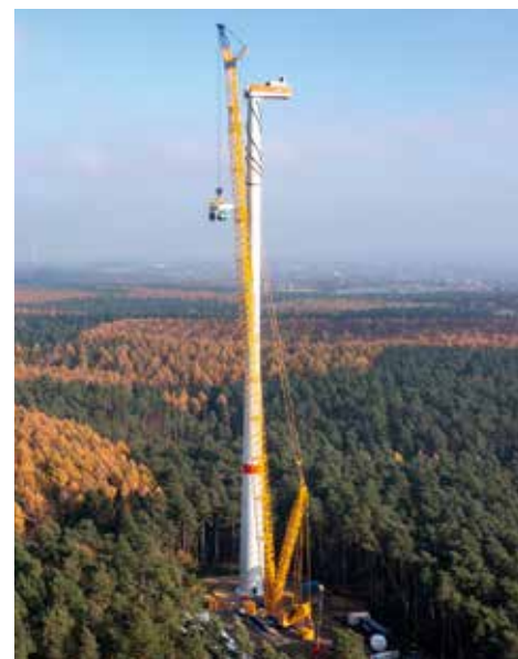
Ersteinsatz in Deutschland: Der LR 1700-1.0 in einem Windpark bei Düsseldorf.
