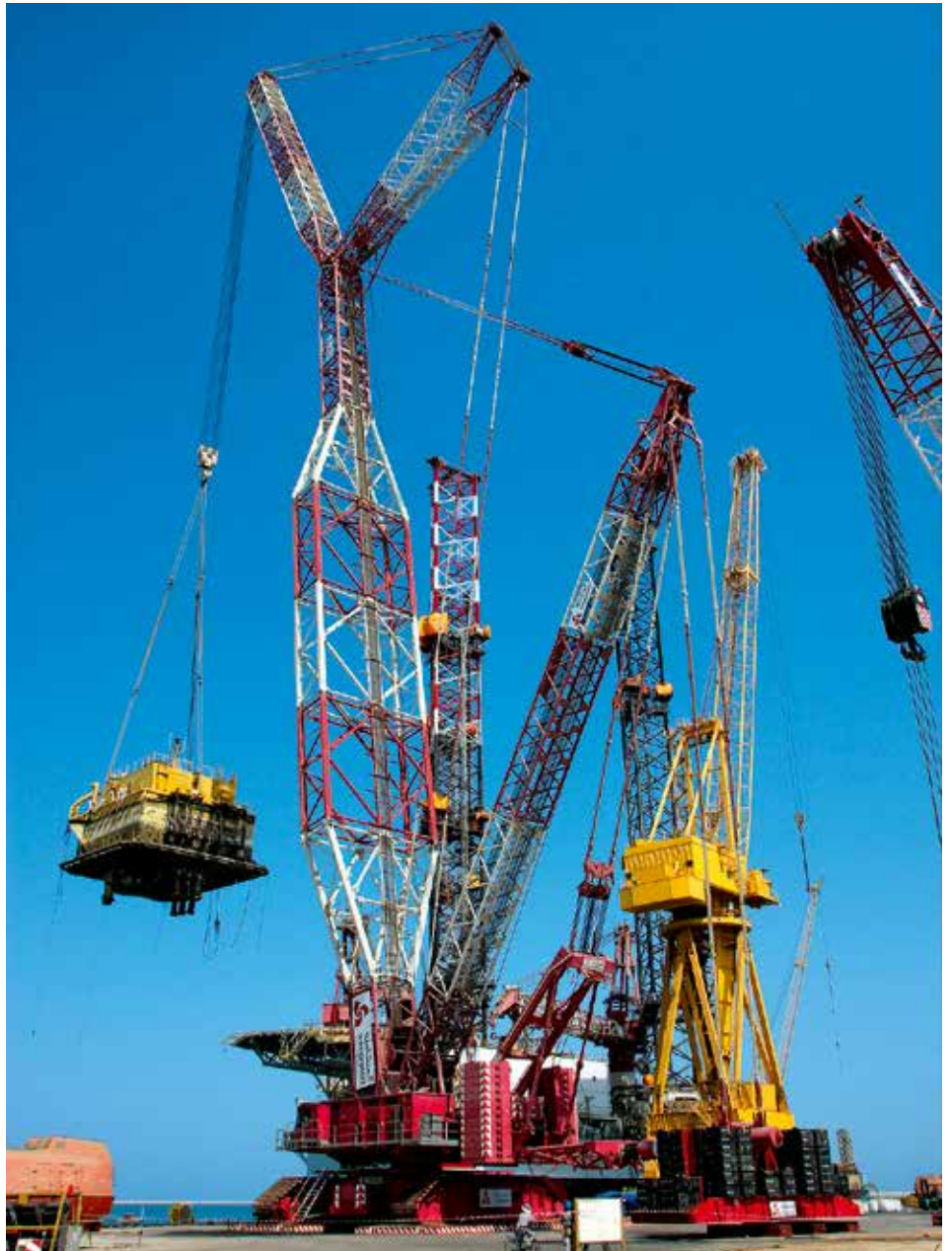
Ein zweiter Raupenkran unterstützt bis die Destillationskolonne senkrecht am Haken des CC8800-1 hängt.
