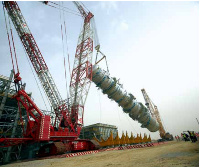
Ein zweiter Raupenkran unterstützt bis die Destillationskolonne senkrecht am Haken des CC8800-1 hängt.
