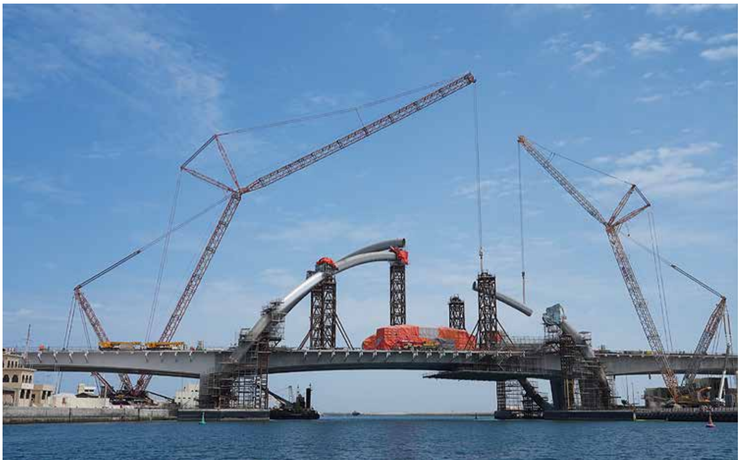
Tandemhub von Brückensegmenten über dem Dubai-Creek.
