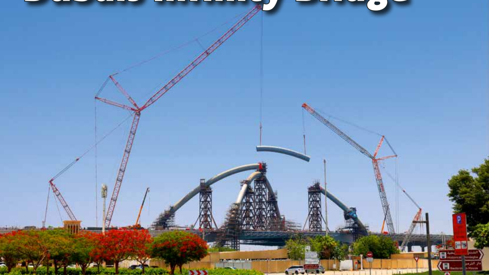
Zwei starke Demag-Raupen heben die Brückensegmente im Tandemhub.
