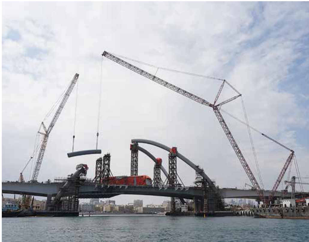
Das letzte Teil des Infinity-Bogens wird eingehoben.
