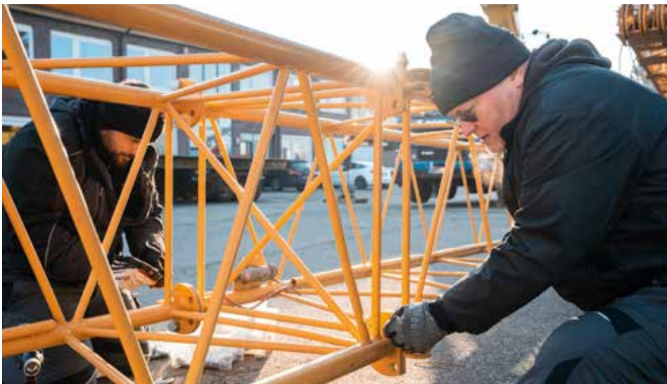
Stephan Keim baut gemeinsam mit Liebherr-Monteuren den für den Transport in seine Einzelteile zerlegten Kran auf.
