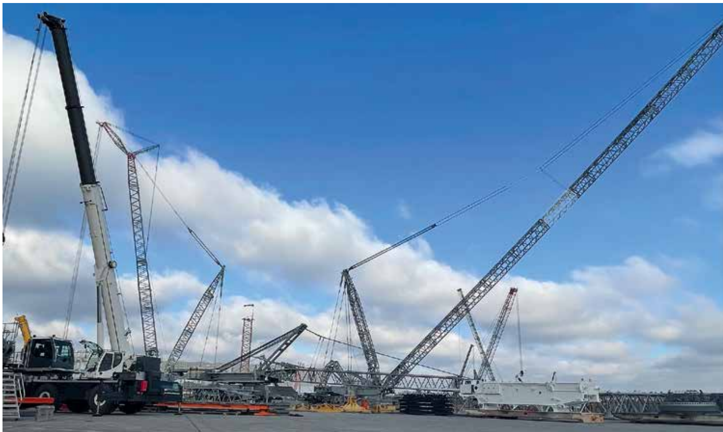
Gittermast-Raupenkran auf dem Liebherr Werksgelände in Ehingen.
