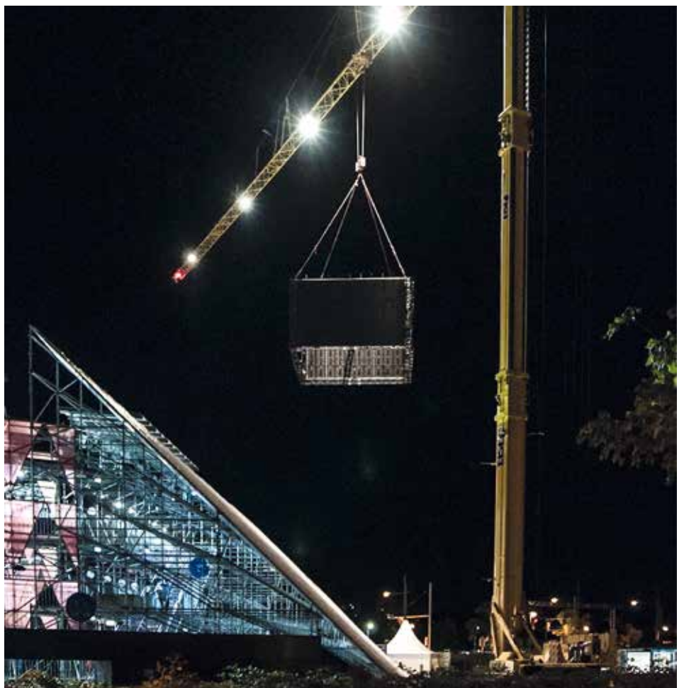
Der MK 110 beim Einsatz in Deutschlands größtem temporären Open-Air-Theater. Foto: Daniel Groß.
