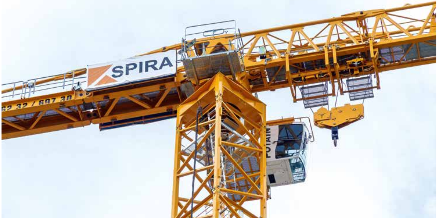
Der nagelneue Potain MDT 569 bei seinem ersten Einsatz am KIT, Karlsruhe.
