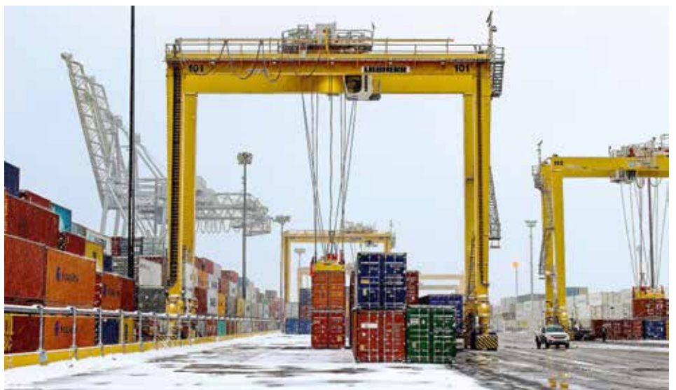
Gummibereifte Portalkräne und STS-Containerkräne im Hafen von Montreal.
