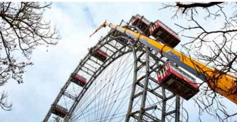
Das zu tauschende Seil wird vertikal über der Nabe positioniert.
