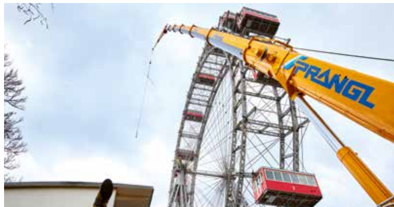
Das alte Seil wird ausgehoben.
