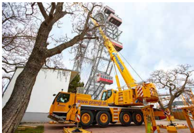
Der Kran legte die freien Seil am vorgesehenen Platz am Boden ab.
