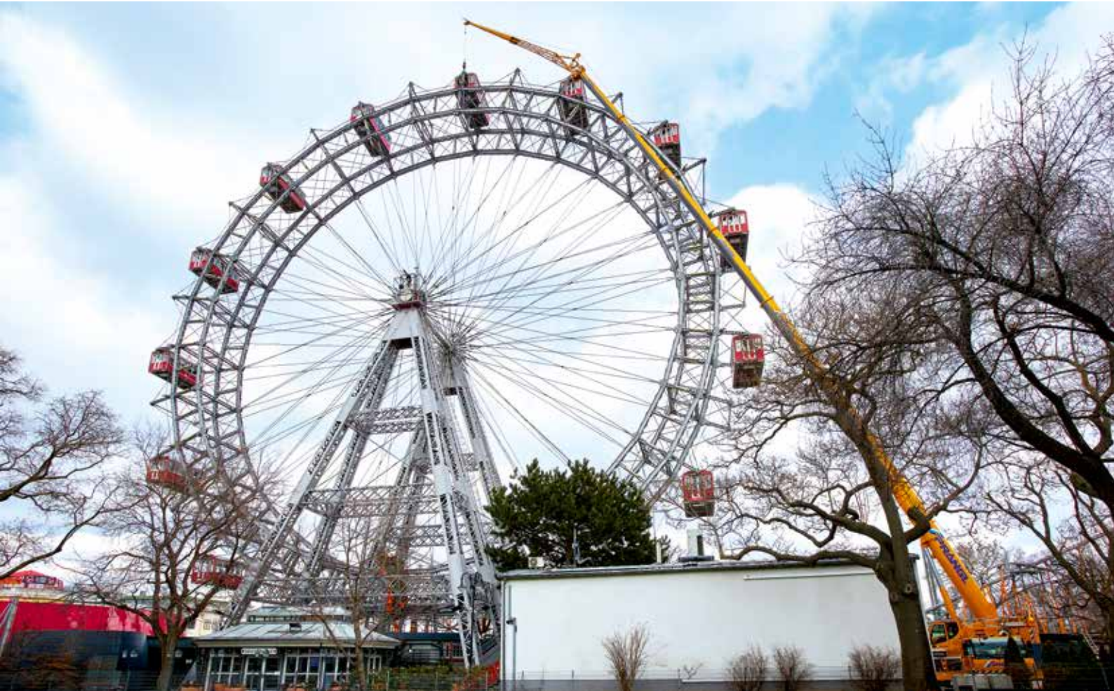
Die neue Seilspeiche wird montiert.
