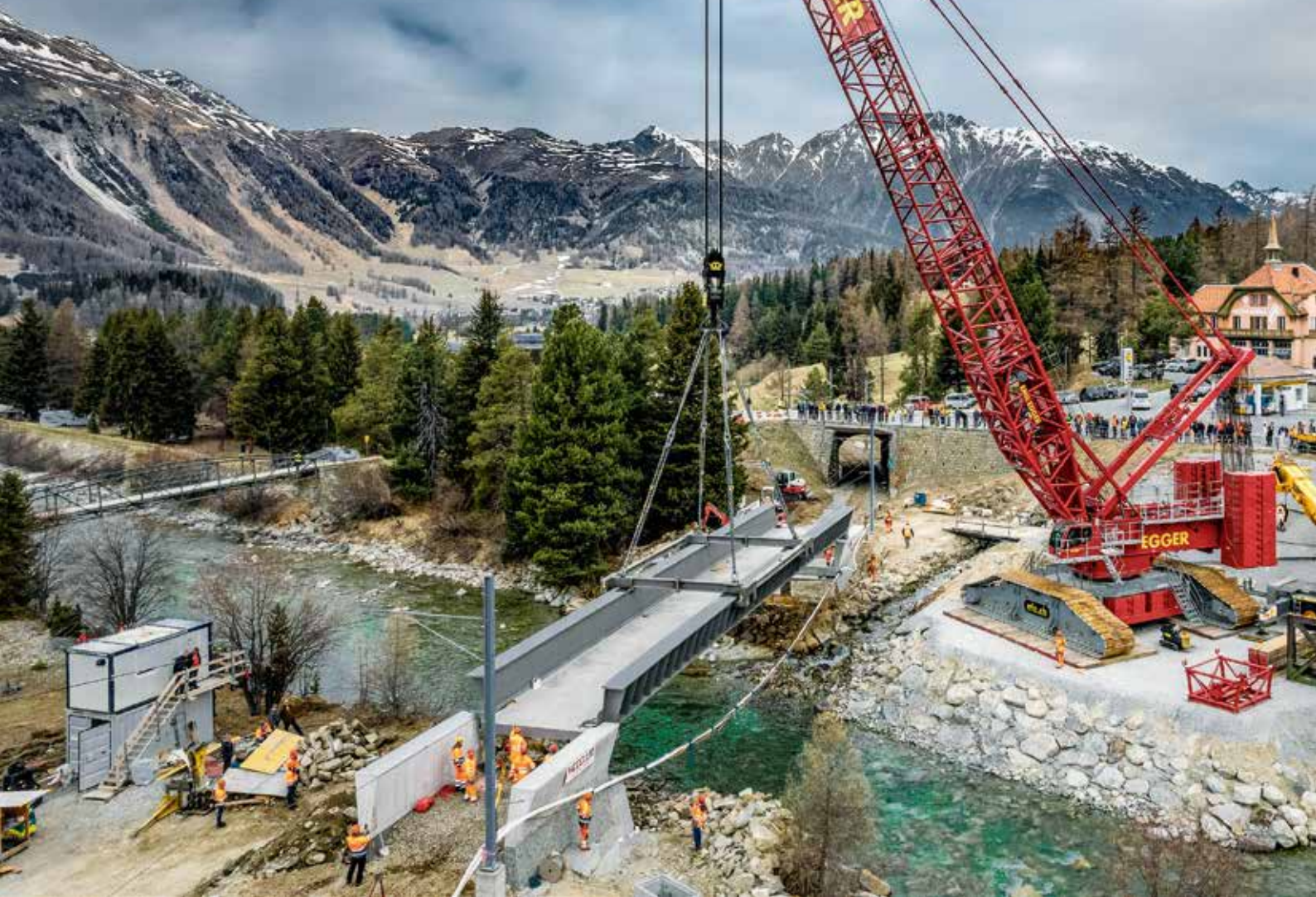
Drangvolle Enge: für Derrickausleger und Schwebeballast ist kein Platz.
